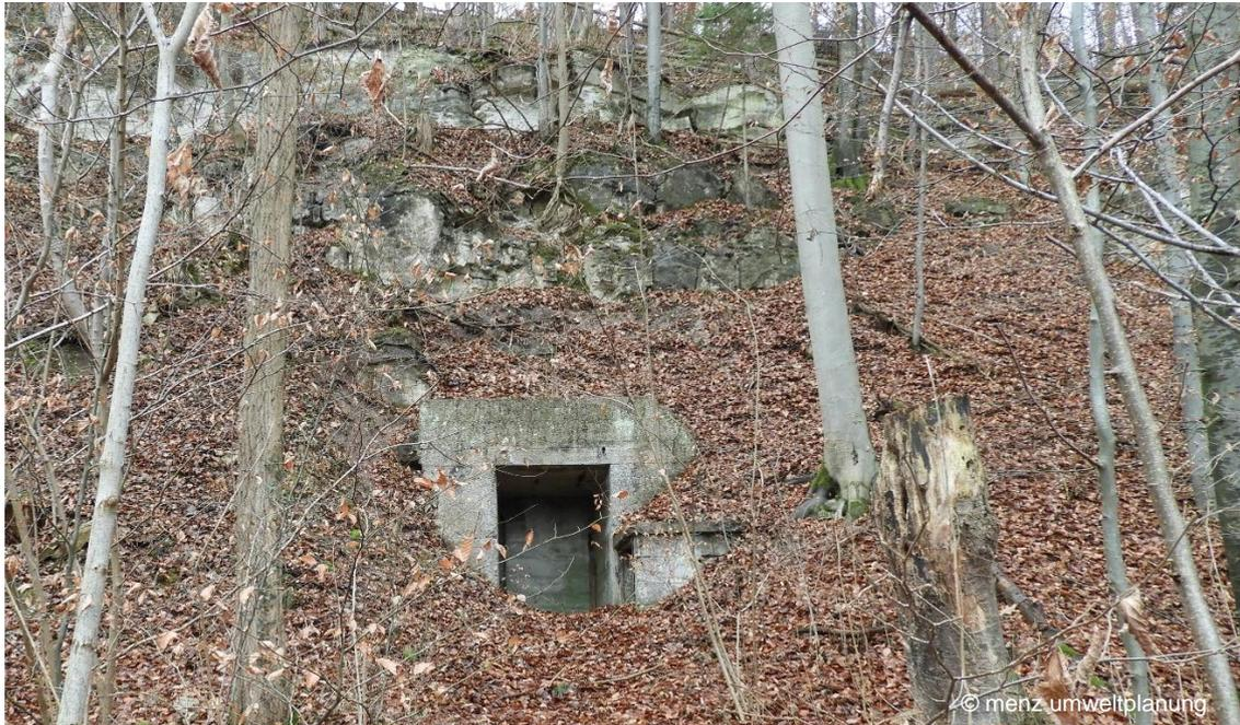
Abb. 2: Unterer Eingang, hier ist Anbringen eines Gitters und Errichtung einer Ausstiegshilfe für Kleintiere erforderlich
