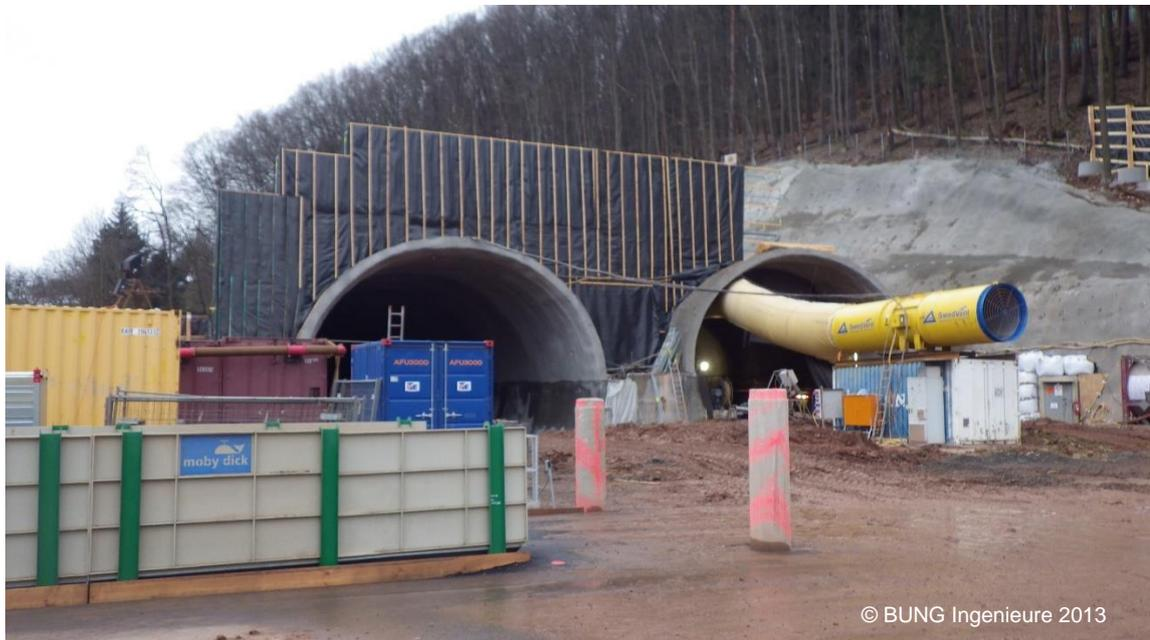
Abb. 2: Beispiel für Konstruktion der Blendschutzwand im Bereich eines Tunnelportals
