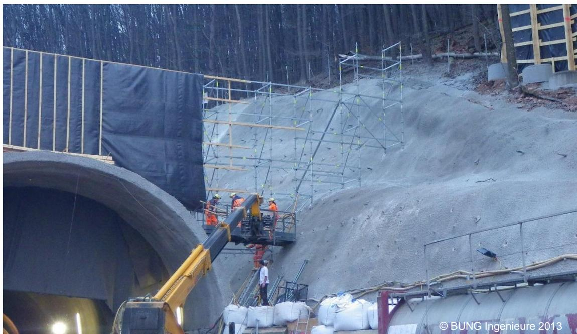
Abb. 3: Beispiel für abschirmende Wirkung einer Blendschutzwand
