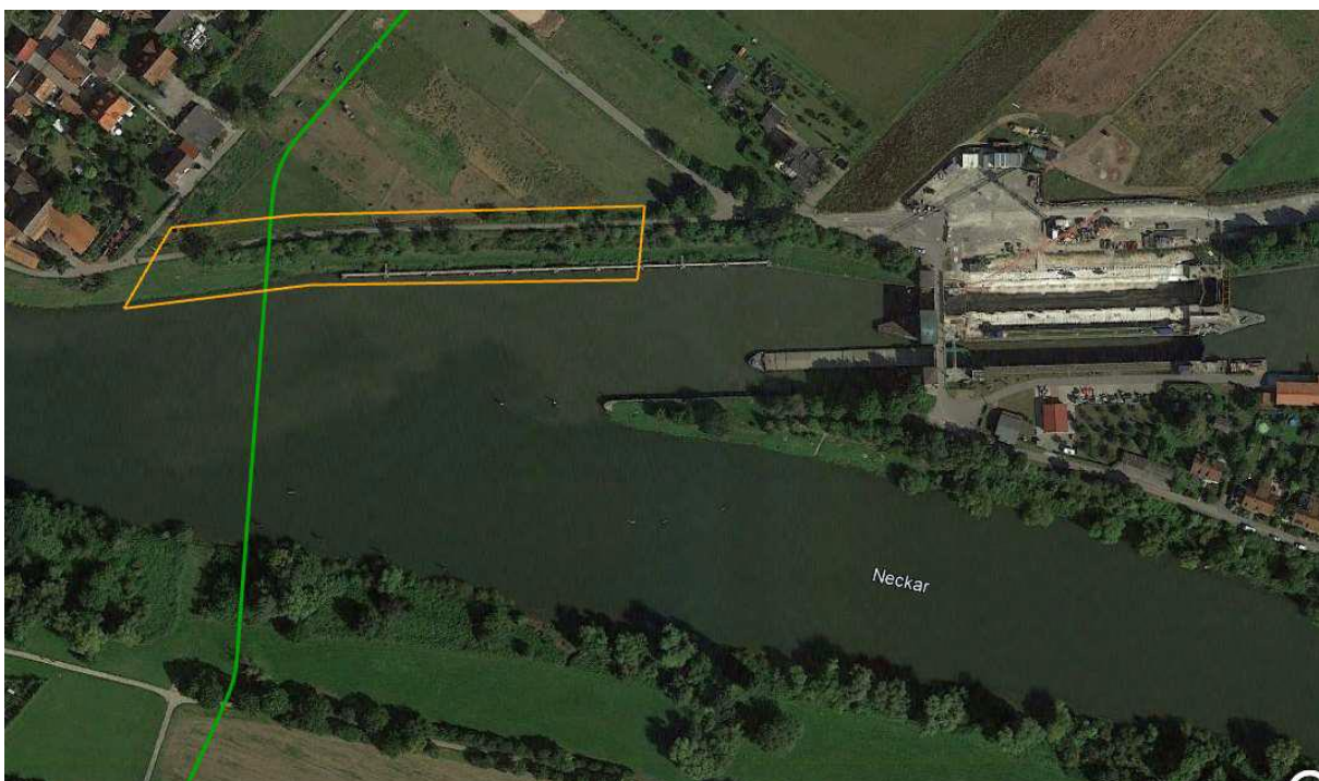
Abb. 12, Lage der geplanten Entnahme- und Wiedereinleitstelle westlich der Schleuse Schwabenheim; in Gelb dargestellt (Quelle: DMT ES; Antragsunterlage 8).
