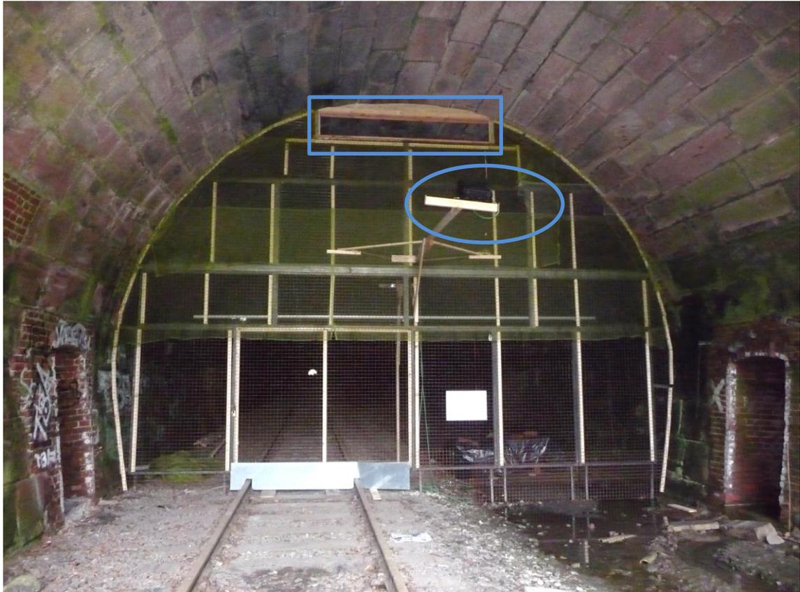
Abbildung 4: Vergittertes Tunnelportal mit deckennaher Lichtschranke (blauer Kasten) und Foto-Monitoring-Einheit (blauer Kreis).
