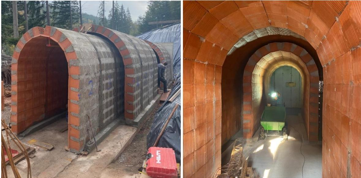
Abbildung 7: Weinkeller-Fertigelement für das Fledermausersatzquartier (Quelle: Zweckverband Hermann-Hesse-Bahn).
