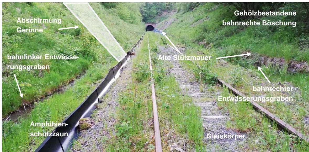
Abbildung 1: Amphibienschutzzaun im Gleisbereich des östlichen VE Tunnel Forst.
