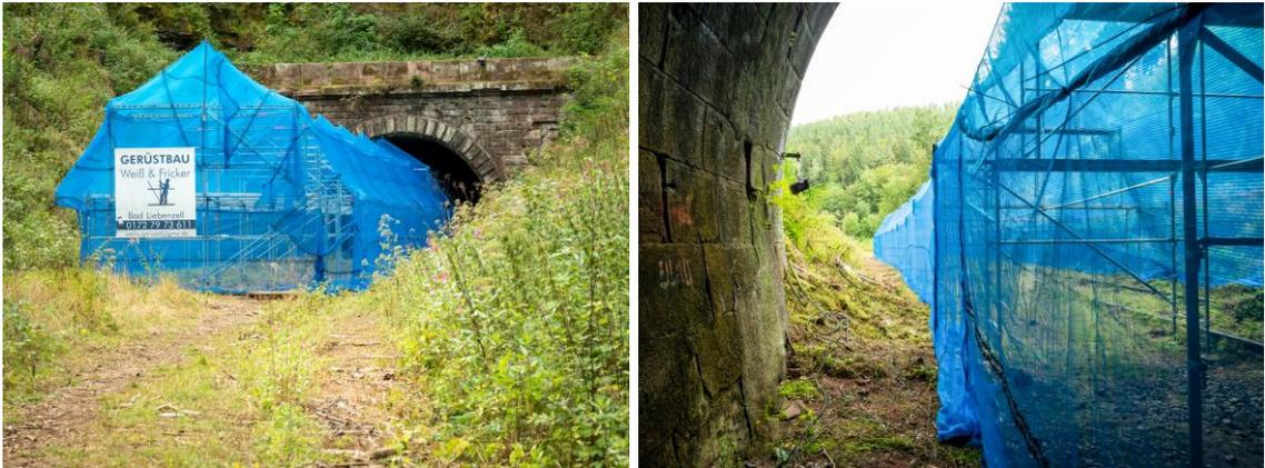
Abbildung 8: Aufgestelltes Baugerüst mit den Abmessungen der geplanten Einhausung/Trennwandkonstruktion.
