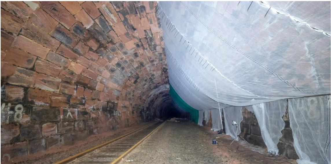
Abbildung 9: Verlängerte Abtrennung durch den ganzen Tunnel.
