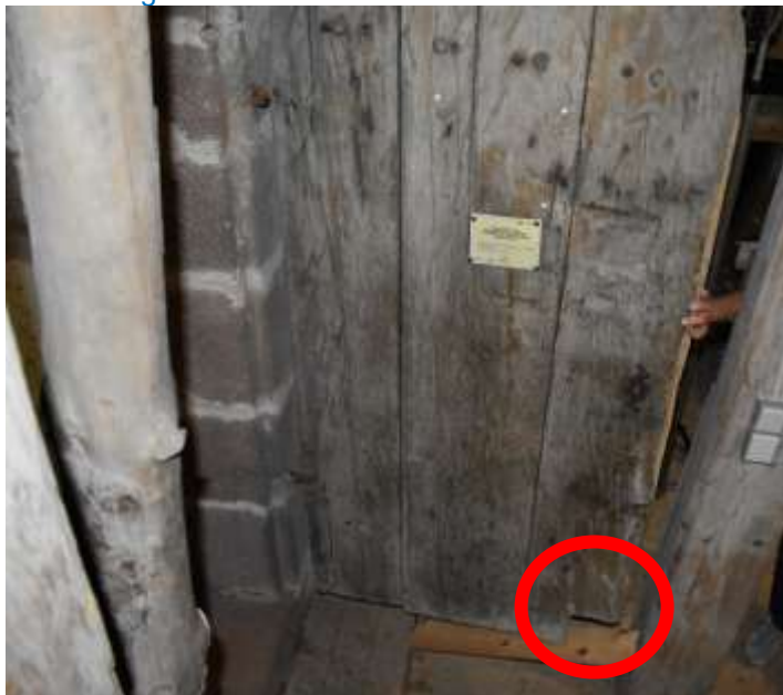
Verbindungstür vom Kirchturm zu den Dachstühlen mit Fledermausöffnung:
