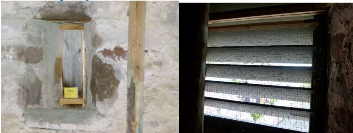
Gesicherte Einflugöffnungen, taubensicher
