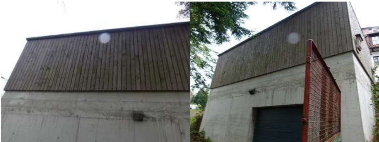
Zusatz 3 = Zentralgebäude, Anbringung von 3 Brettern (Markierung roter Stern; an größten Abständen zwischen den Fenstern bzw. an Stirnseite)
