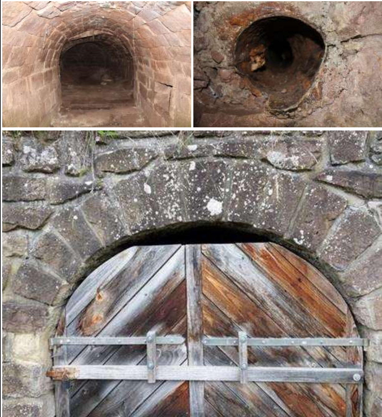
Abbildung 48: Eiskeller Bad Liebenzell (Beinberger Steige). Links: Blick in den Eiskeller, rechts: Lüftungsrohr im Eingangsbereich, unten: bestehende Eingangstür.
