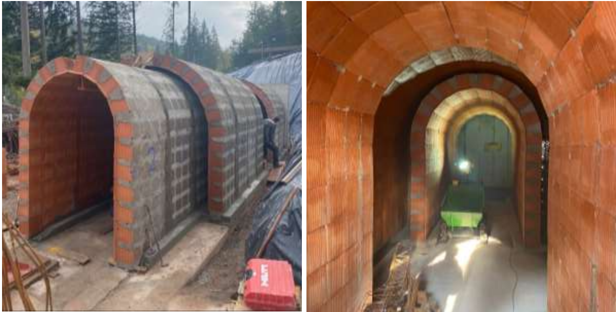
Abbildung 6: Weinkeller-Fertigelement für das Fledermausersatzquartier (Quelle: Zweckverband Hermann-Hesse-Bahn).
