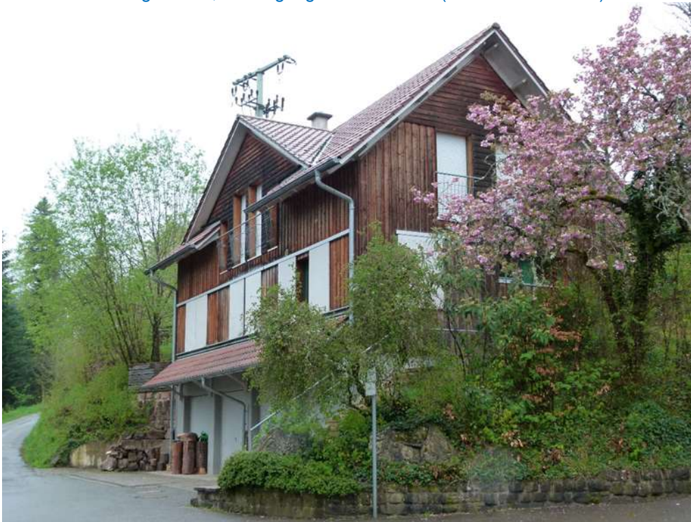
Zusatz 1 = Wohngebäude, Anbringung von 4 Brettern (1 Brett/First/Giebel)
