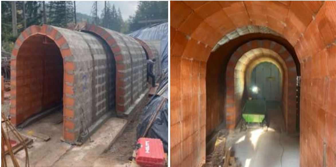
Abbildung 9: Weinkeller-Fertigelement für das Fledermausersatzquartier (Quelle: Zweckverband Hermann-Hesse-Bahn).
