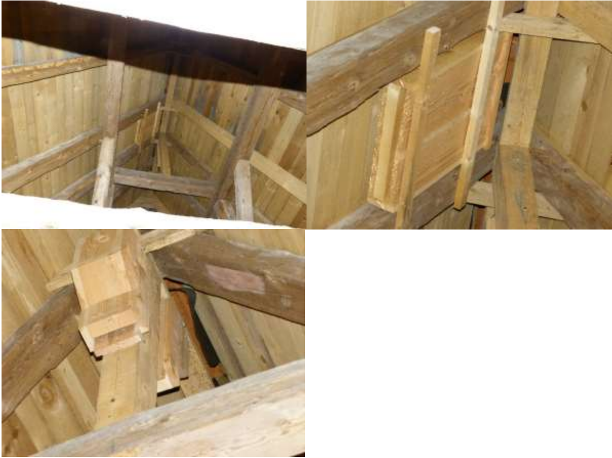
Gesicherte Einflugöffnungen, taubensicher
