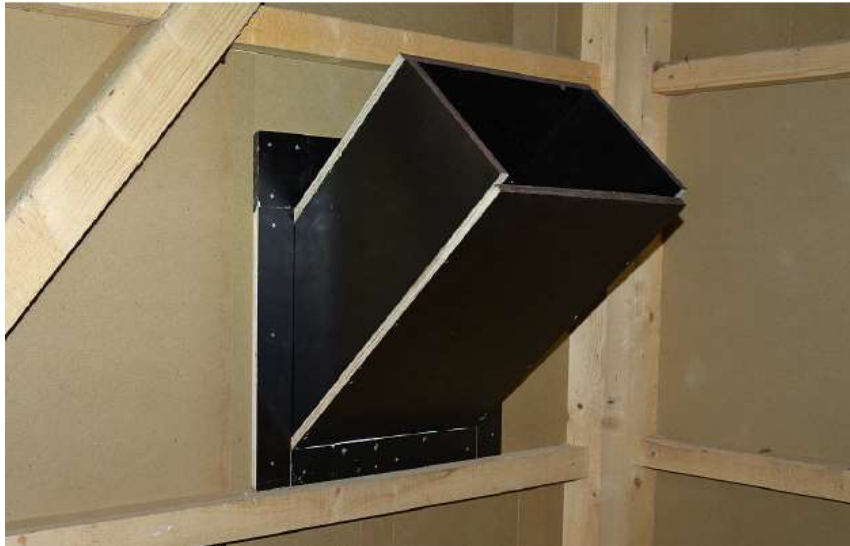
Abbildung 15: Innenansicht Einflugschacht. (Quelle Dietz)
