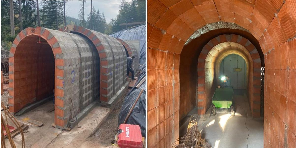
Abbildung 6: Weinkeller-Fertigelement für das Fledermausersatzquartier (Quelle: Zweckverband Hermann-Hesse-Bahn).
