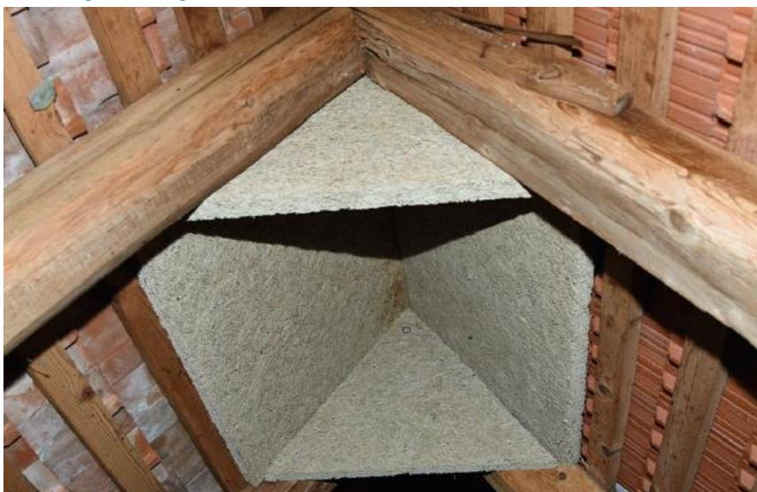
Abbildung 13: Wärmeglocke aus Heraklith in einem Sparrendach (Quelle Dietz)
