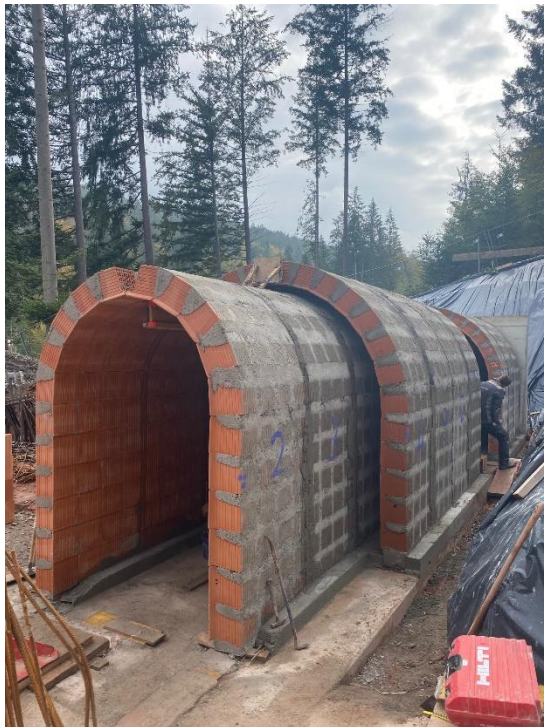
Abbildung 5: Tonnengewölbe-Fertigelement für das Fledermausersatzquartier (Quelle: Zweckverband Hermann-Hesse-Bahn).
