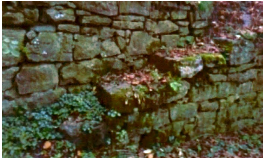
Nr. 167: Steintreppe an alter Steinmauer bei der Burgmühle
