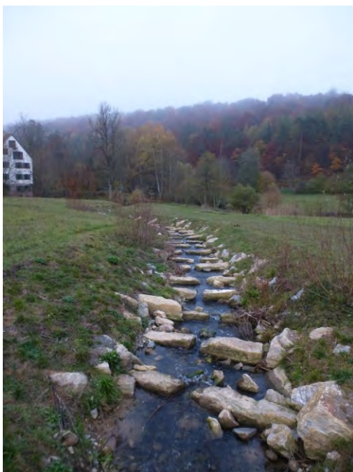
Bild 1: Umgehungsgerinne des Strudelbachs oberhalb der Ölmühle, intensive Verbauung mit Blocksteinspornen, November 2015.
