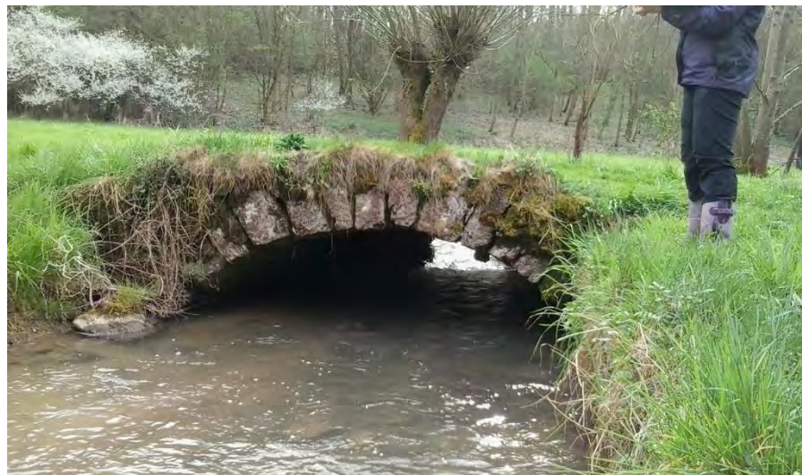
Kleindenkmal Nr. 8.3 Bogenbrücke
