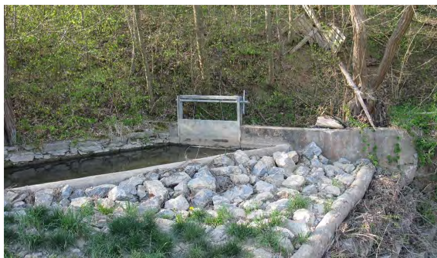
Ohne Nr.: Altes Einlaufbauwerk für den Mühlkanal zur Ölmühle
