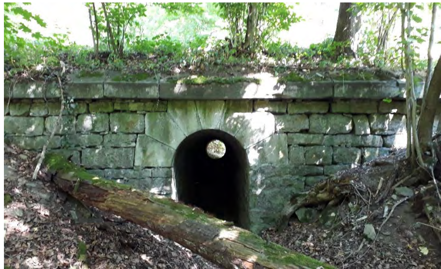
Kleindenkmal Nr. 7.3 Brücke Hochwasserdurchlass
