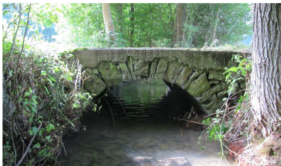
Kleindenkmal Nr. 8.5 Bogenbrücke
