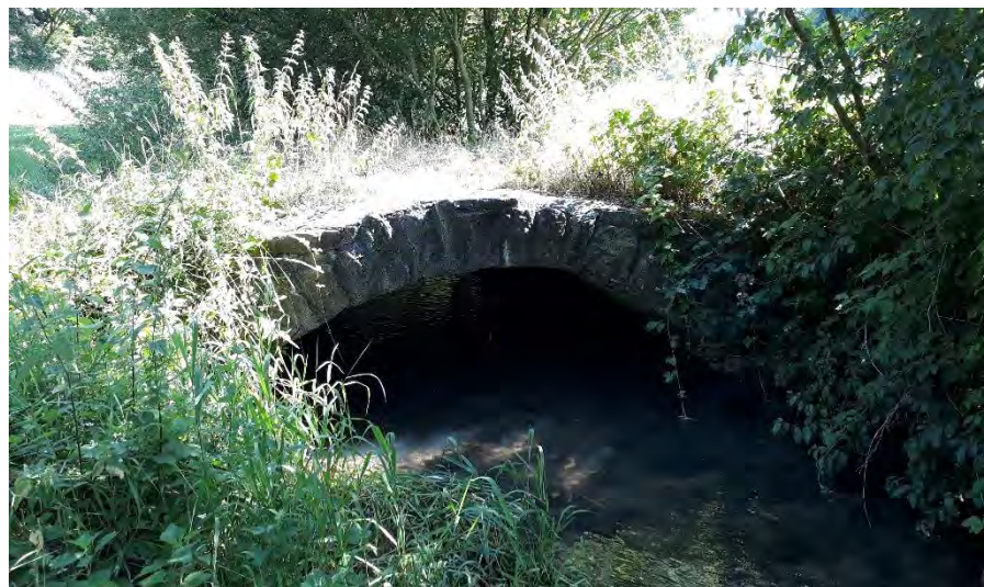
Kleindenkmal Nr. 8.4 Bogenbrücke
