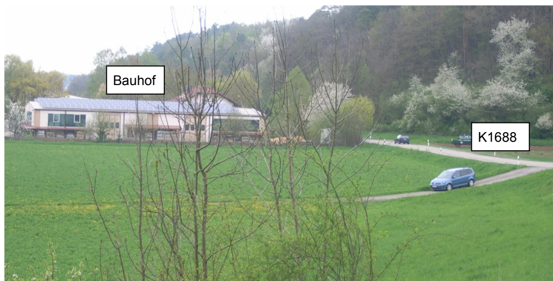
Abbildung 4: Bestehende Abfahrt K1688
