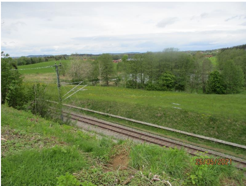
Abb. 5: Blick vom südlichen Brückenwiderlager auf den Bereich der geplanten GVS-Trasse. Um den Höhenunterschied auszugleichen, ist auf der Wiese eine Dammschüttung für die GVS erforderlich.
