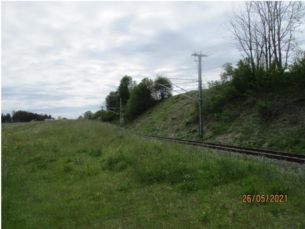
Abb. 4: Blick auf den Böschungsbereich an dem die Brücke über die Bahn gebaut wird. Für den Bau des Widerlagers ist der Gehölzbewuchs auf der Bahnböschung bereits entfernt worden.
