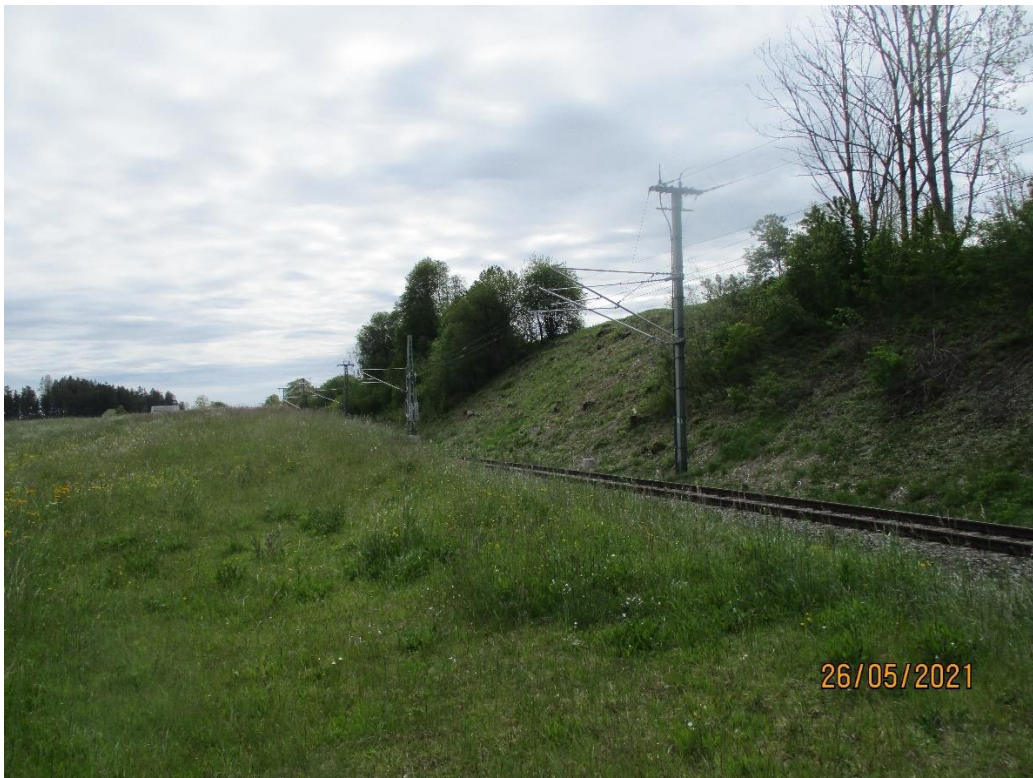
Abb. 4: Bei der Elektrifizierung der Bahnstrecke ist der geplante Brückenbau bei der Konstruktion der Oberleitung bereits berücksichtigt worden.
