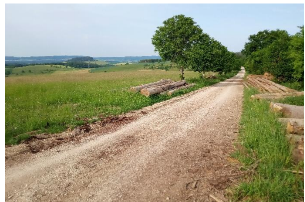
Die Zuwegung verläuft entlang des Alten Postweges zwischen Baumreihen, der Seitenstreifen wird zum Lagern von Holz genutzt.
