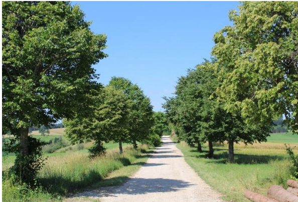
Der Alte Postweg wird auf eine Breite von 4,5 m ausgebaut. Teilweise sind die Bäume zurück zu schneiden, um das Lichtraumprofil von 6 m einhalten zu können.
