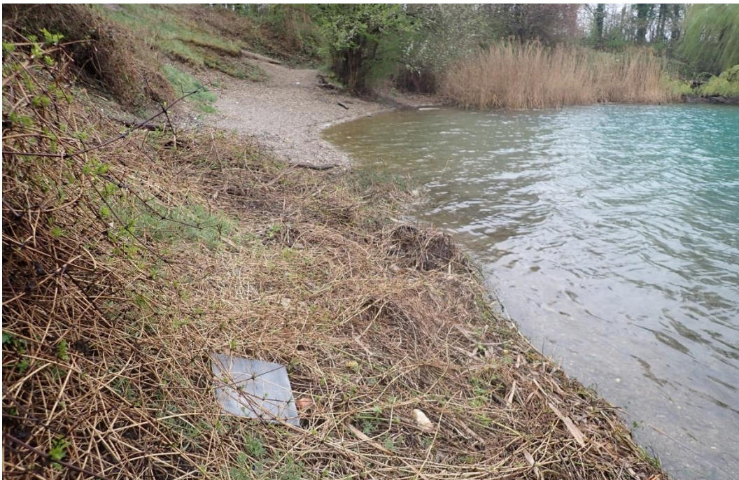
Abbildung 7.1-1. Ausgebrachte Schlängelmatte (Aufnahme am 01.04.2022).
