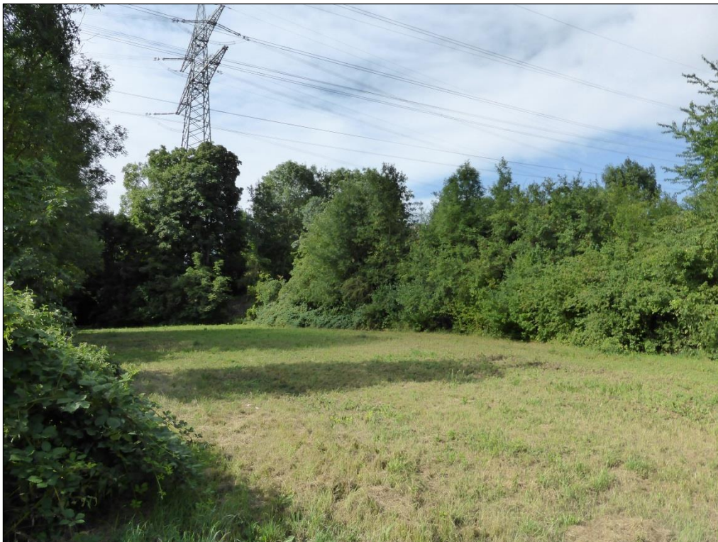
Foto 8: Neckartalhang auf Höhe der Buchener Straße (=Landschaftsschutzgebiet), Blick nach Westen, mit Freileitung, Aufnahme vom 21.07.2015
