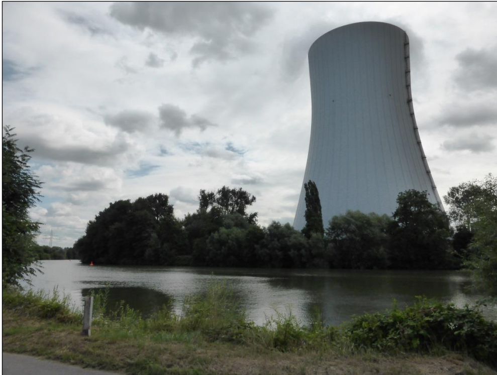
Foto 1: Neckarufer und Heizkraftwerk der EnBW auf der östlichen Neckarseite, Blick nach Nordosten, Aufnahme vom 21.07.2015
