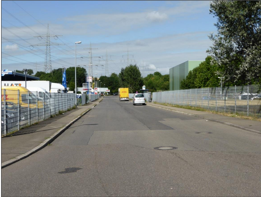
Foto 7: Buchener Straße im Industrie- und Gewerbegebiet „Neckarau“, Blick nach Westen, links Auto-Service Fischer und Freileitung, rechts Firmengelände Friesland Campina, Aufnahme vom 21.07.2015
