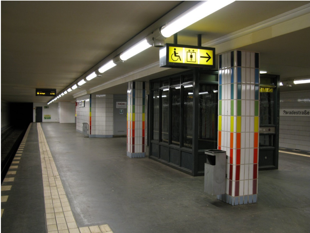
Abb. 10 Foto vom Bahnsteigbereich
