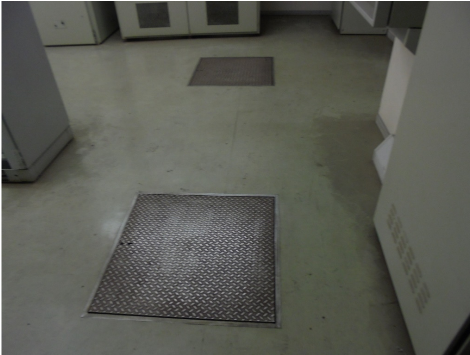
Abb. 19: Übersichtaufnahme von Bodenöffnungen im Raum Nr. 205, die auf feuerbeständige Ausbildung geprüft werden müssen
