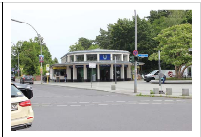
Objekt 78 U-Bahnhof Krumme Lanke
