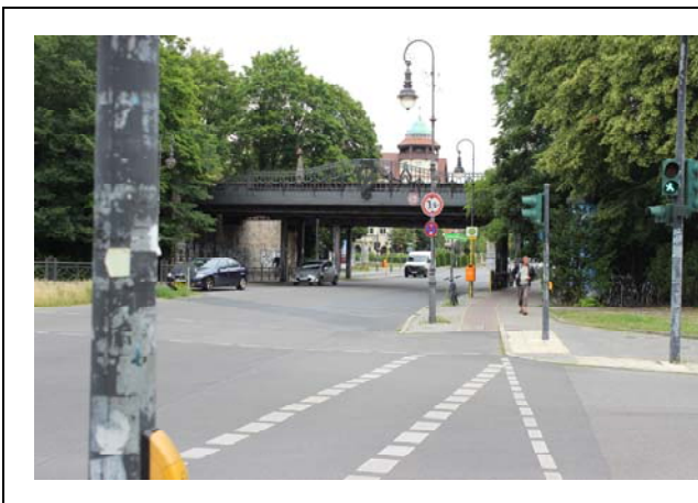
Objekt 77 S-Bahnhof Mexikoplatz
