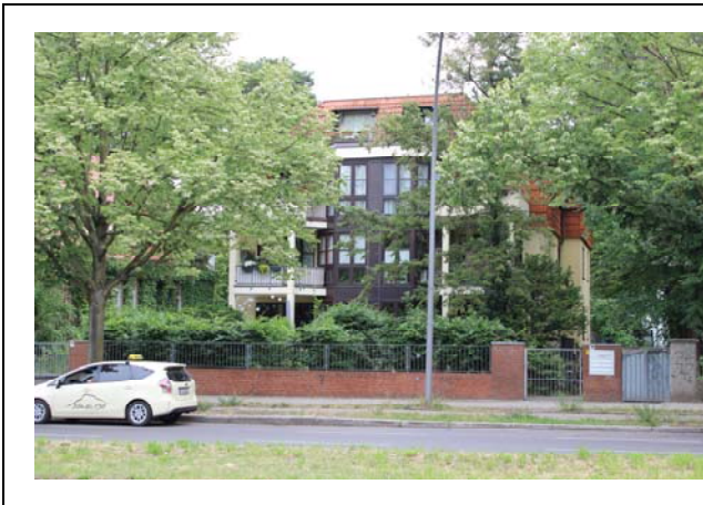
Objekt 69 Lindenthaler Allee 26
