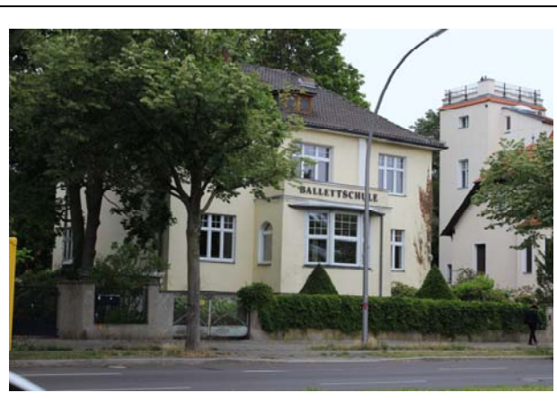
Objekt 12 Lindenthaler Allee 11
