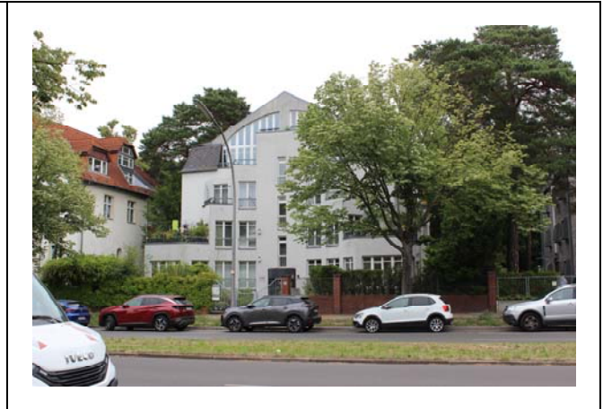
Objekt 74 Lindenthaler Allee 36
