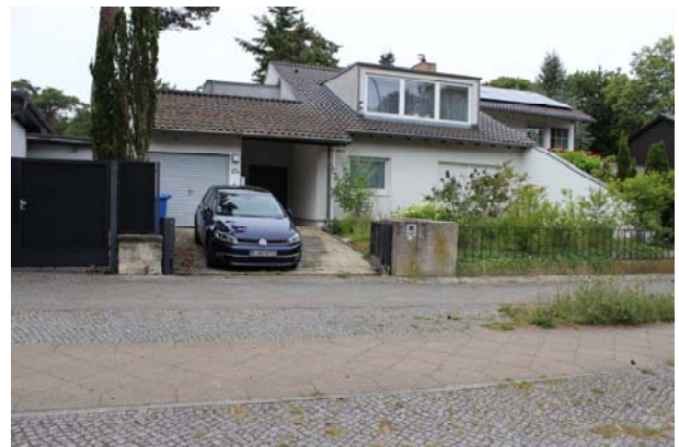
Objekt 02 Lindenthaler Allee 27A
