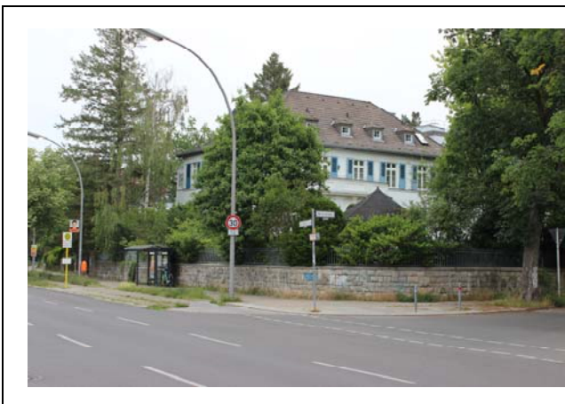
Objekt 65 Lindenthaler Allee 20
