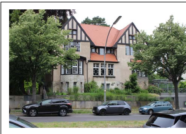
Objekt 17 Lindenthaler Allee 5
