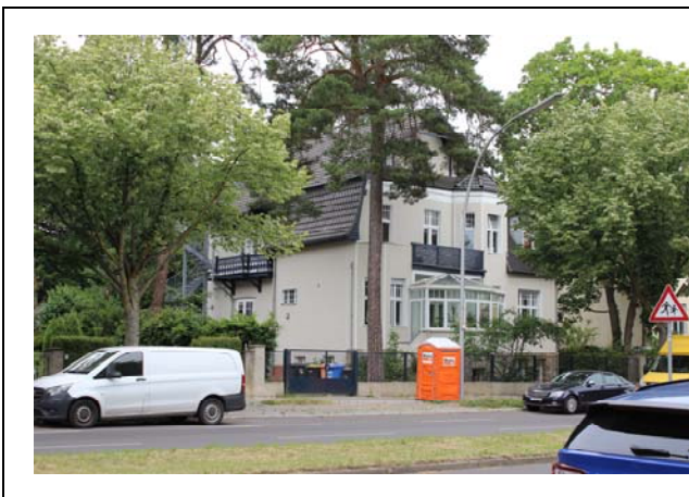
Objekt 11 Lindenthaler Allee 15
