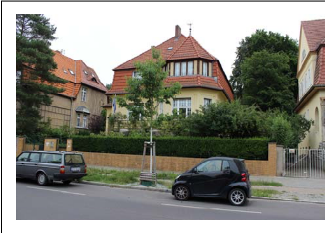
Objekt 61 Lindenthaler Allee 12
