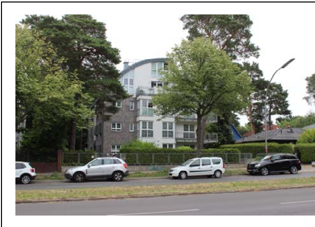
Objekt 75 Lindenthaler Allee 38
