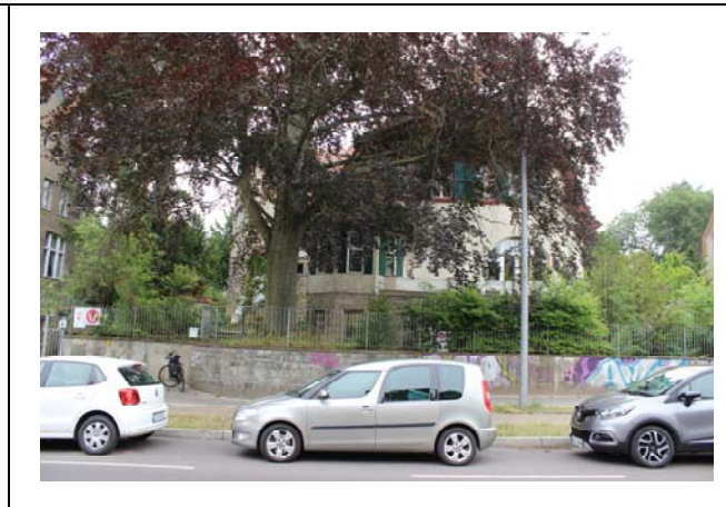
Objekt 58 Lindenthaler Allee 6
