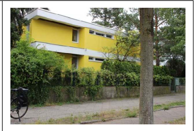
Objekt 64 Lindenthaler Allee 18, 18A
