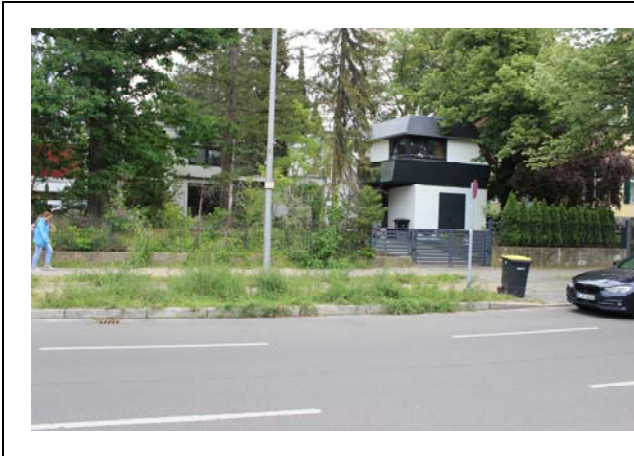
Objekt 67 Lindenthaler Allee 22
