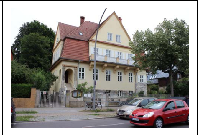
Objekt 62 Lindenthaler Allee 14
