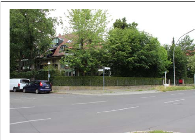
Objekt 09 Lindenthaler Allee 21
