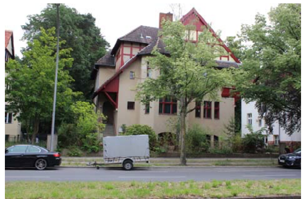
Objekt 72 Lindenthaler Allee 32
