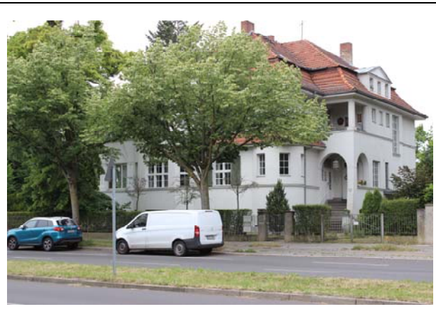
Objekt 10 Lindenthaler Allee 17
