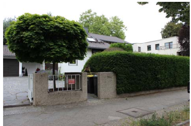
Objekt 04 Lindenthaler Allee 25A
