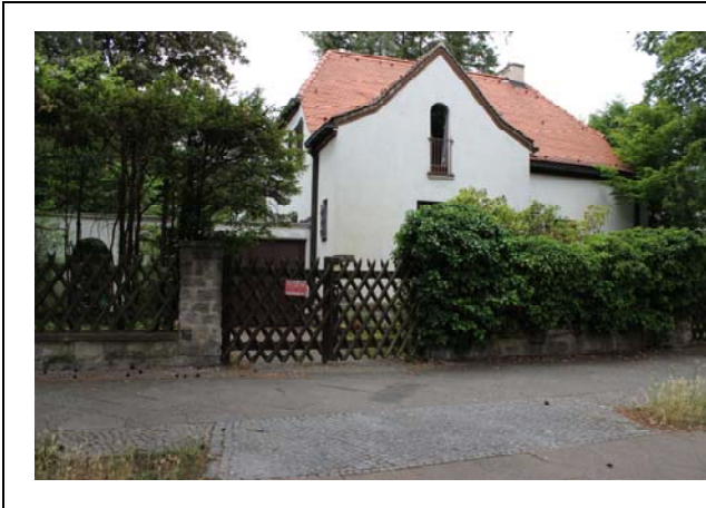
Objekt 07 Lindenthaler Allee 21A
