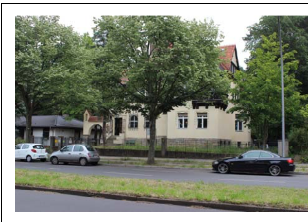
Objekt 71 Lindenthaler Allee 30
