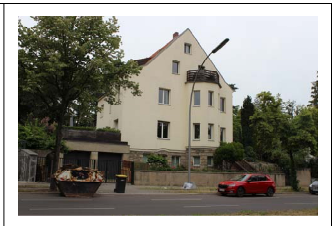
Objekt 18 Lindenthaler Allee 3
