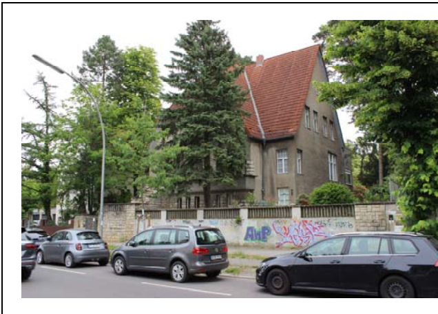
Objekt 57 Lindenthaler Allee 4
