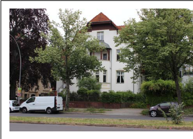
Objekt 73 Lindenthaler Allee 34
