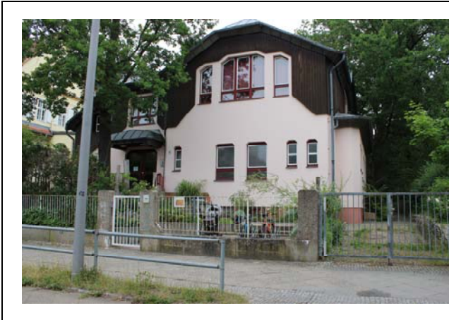
Objekt 63 Lindenthaler Allee 16
