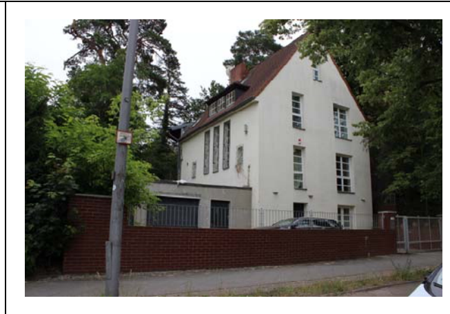
Objekt 56 Lindenthaler Allee 2A
