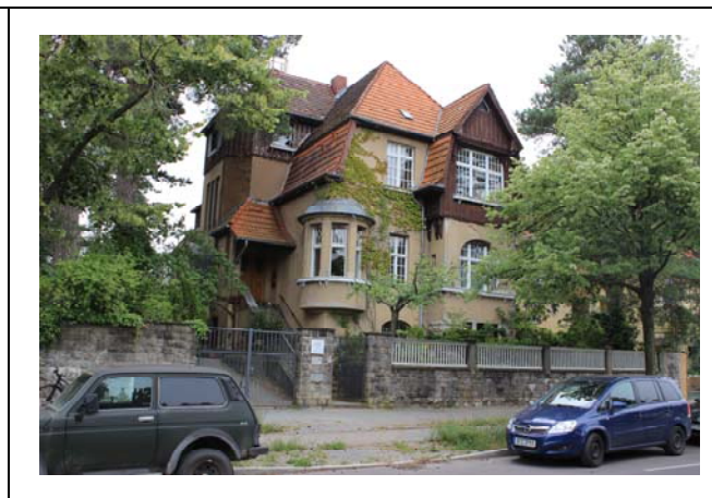
Objekt 60 Lindenthaler Allee 10
