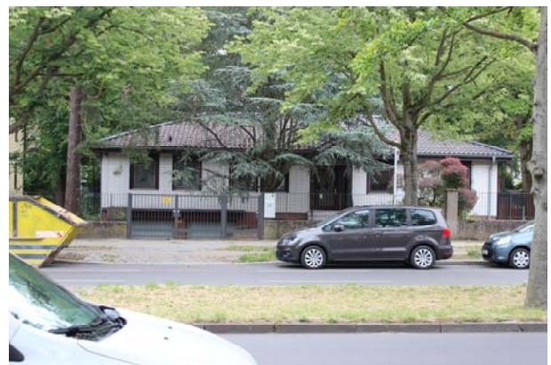
Objekt 70 Lindenthaler Allee 28
