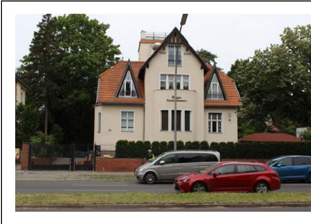
Objekt 13 Lindenthaler Allee 9
