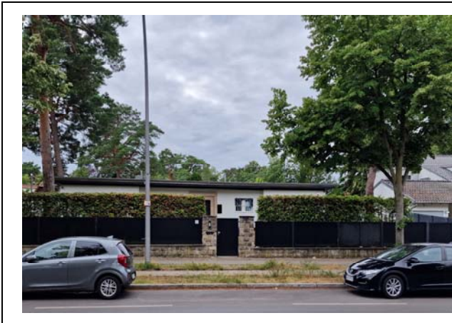
Objekt 01 Lindenthaler Allee 29
