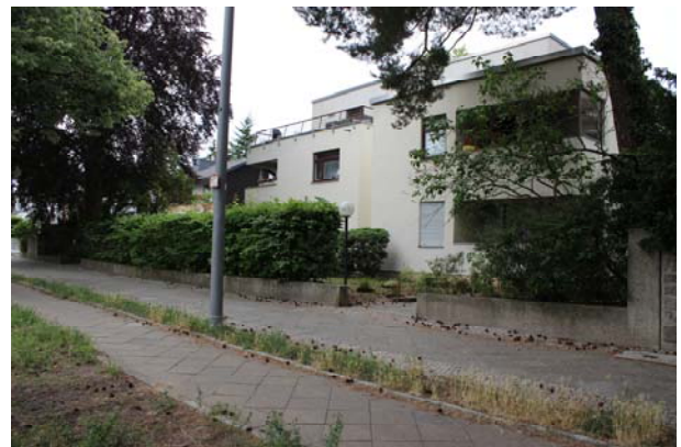
Objekt 06 Lindenthaler Allee 23
