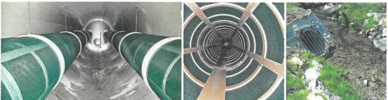
Beim Amiscreen-System findet die Grobstoffrückhaltung (> 8 mm) nicht mehr an der Regenüberlauf-Schwelle sondern im Rohrspeicher des Stauraumkanals statt. Mehrere sehr lange perforierte Stränge bilden eine riesige Rechenfläche, die hierbei nicht mehr verstopft. Die Grobstoffe werden zu 100 % zurückgehalten und verbleiben komplett im Stauraumkanal. Sie gelangen nicht mehr in die freie Natur.
