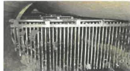
Ein kompakter Regenüberlauf (RÜ), der sich gut in einen Mischwasserkanal einbinden lässt. Durch eine vorgeseetzte Beruhigungs-kammer und über bewegliche Stabrechen werden Grobstoffe im Kanal zurückgehalten.
