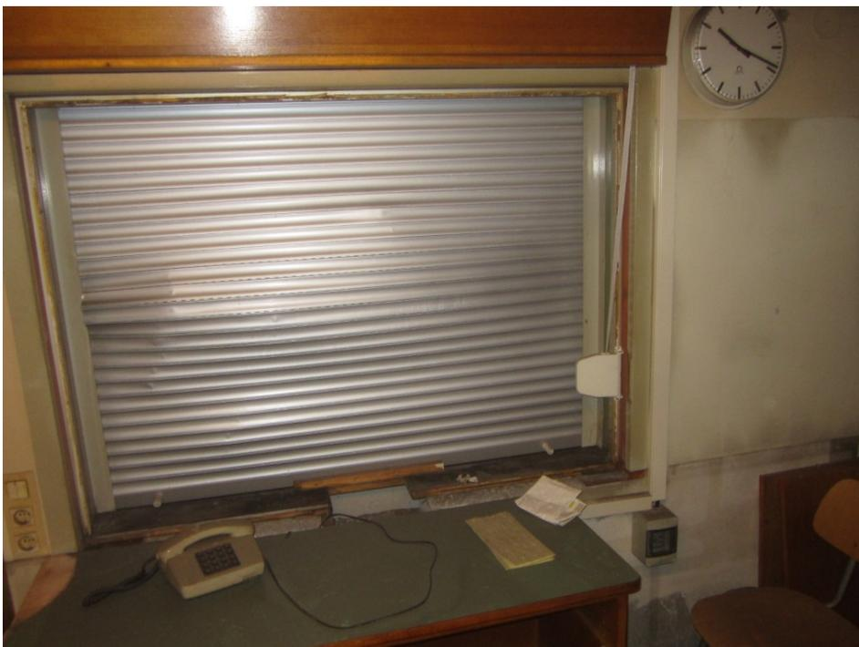
**Abb. 14:** Beispiel einer nicht feuerbeständig verschlossenen Öffnung vom Raum 262 zur Schalterhalle II
