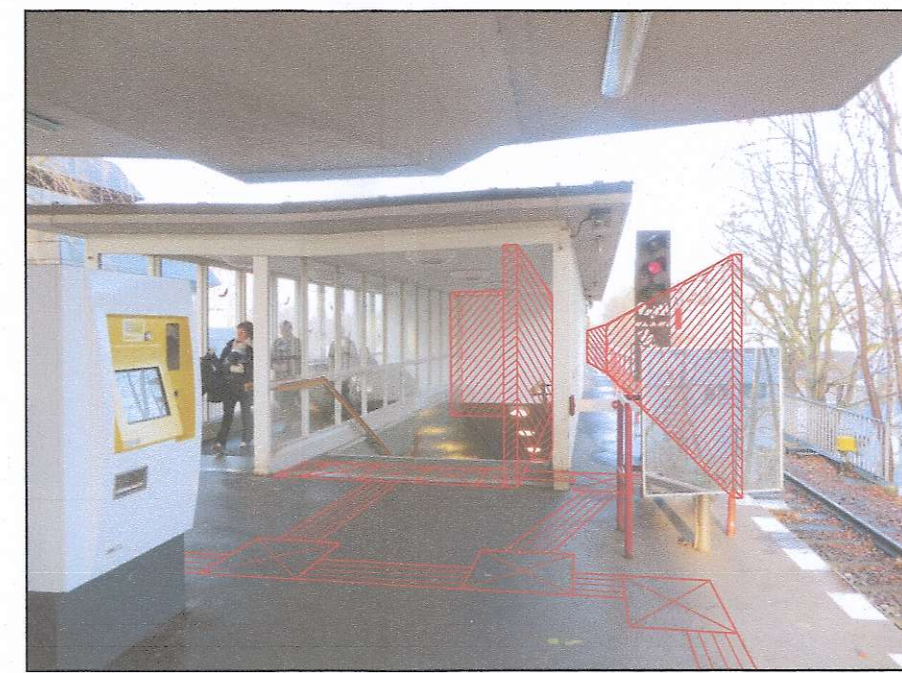
Blick vom Bahnsteig auf den Abgang zur Verteilerhalle
