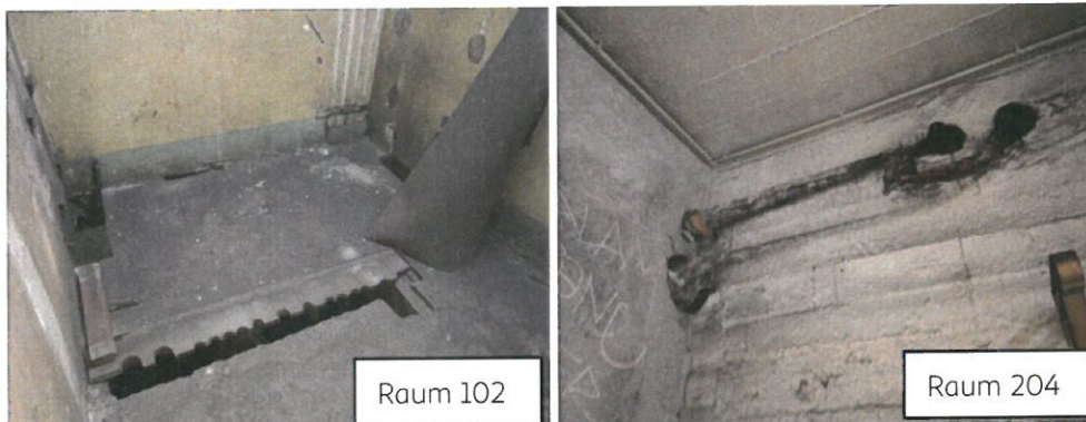
Abbildung 10 Zu schließende Öffnungen
