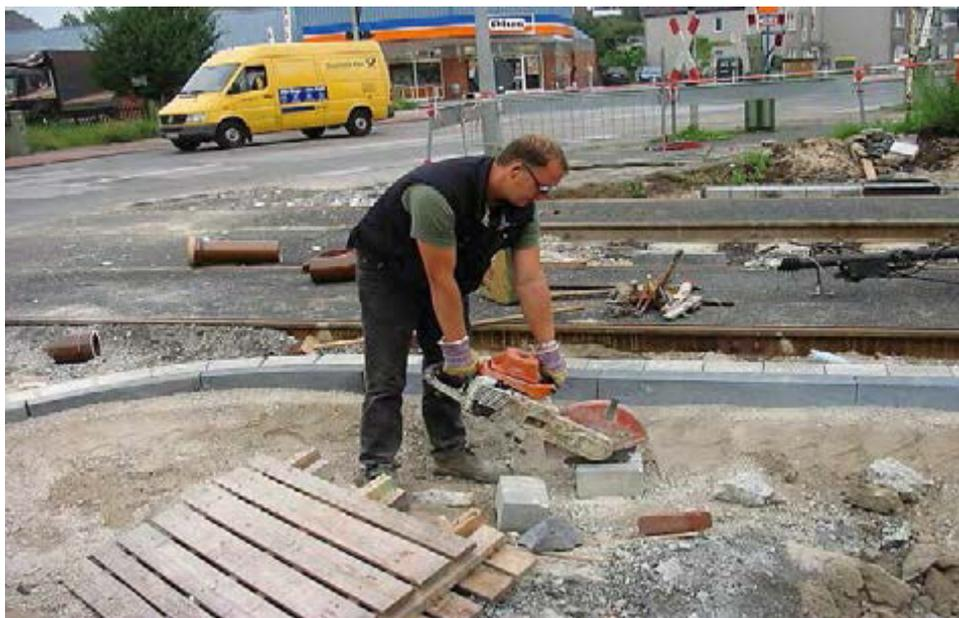
Steine werden zum Verlegen mit Diamantsägeblatt freihändig geschnitten
