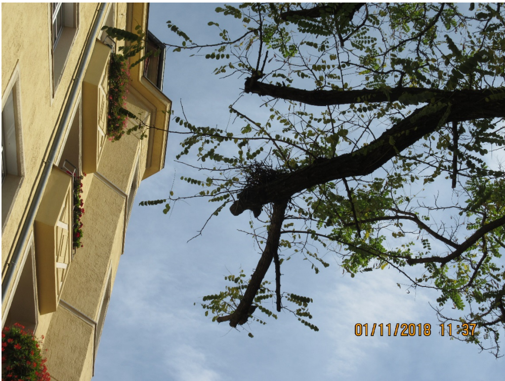
Abb.:8. Grobastabschnitte gebäudeseitig, unbewohntes Nest
