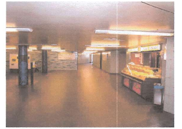
Verteilerhalle Gleis 1, Blickrichtung Gang II/1
