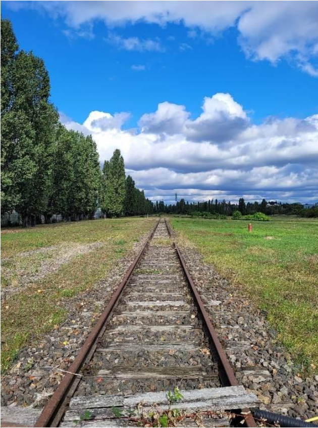
Abbildung 10: Gleisbett im Westen des Gebiets. Das Schotterbett ist noch gut zu erkennen.
