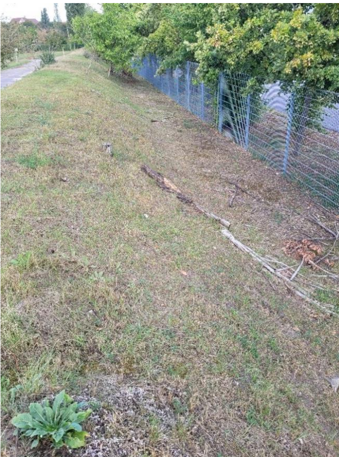
Abbildung 15: Trocken-magerer Erdwall mit Gehölzbepflanzung (Walnussbaum im Hintergrund). Links oben im Bild ist der Hauptzufahrtsweg (teilversiegelt mit Betonplatten) zu erkennen.
