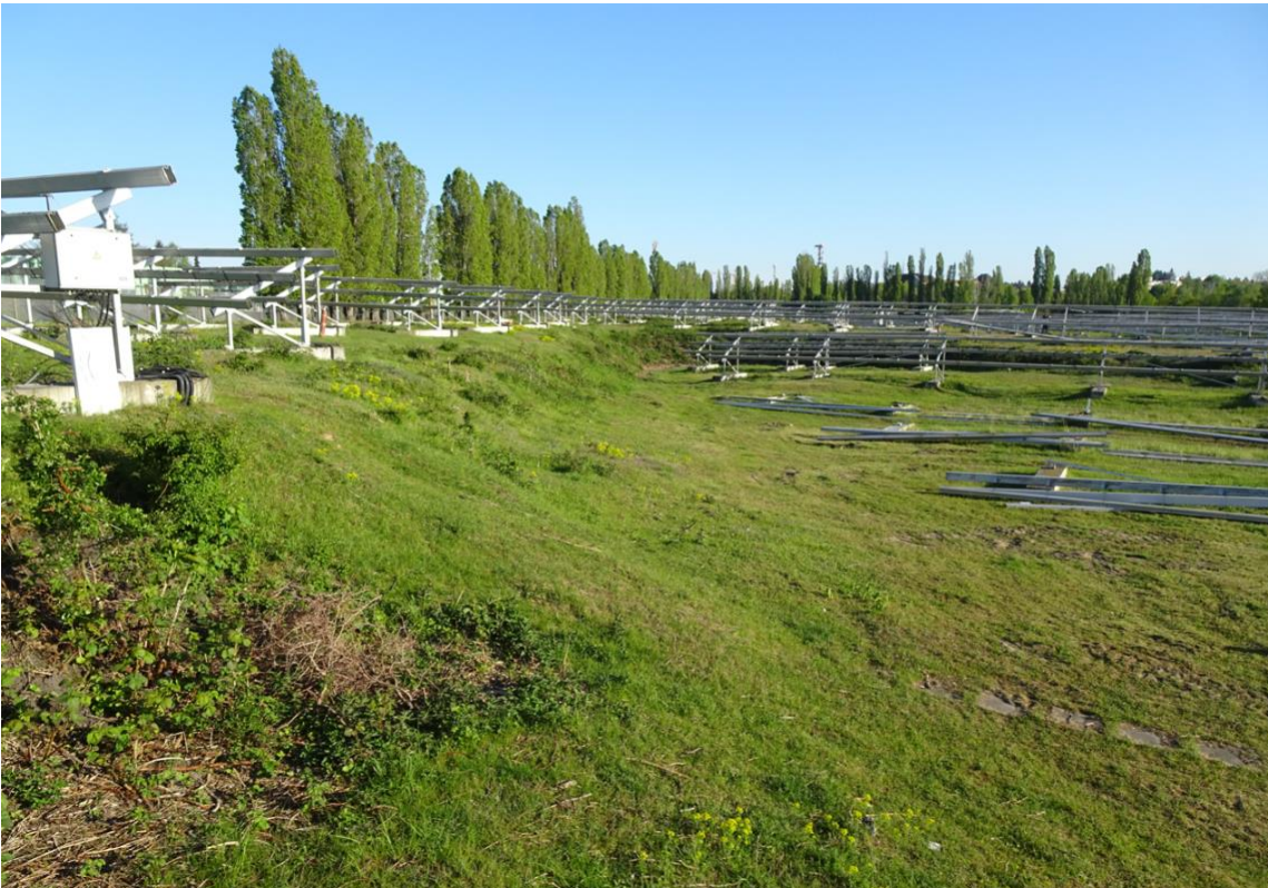
Abbildung 19: Das Untersuchungsgebiet (Blickrichtung Nord) mit teildemontierten Solargesteellen. Die Hangkante sowie die Pappelreihe grenzen das Areal zur Bahnstrecke ab
