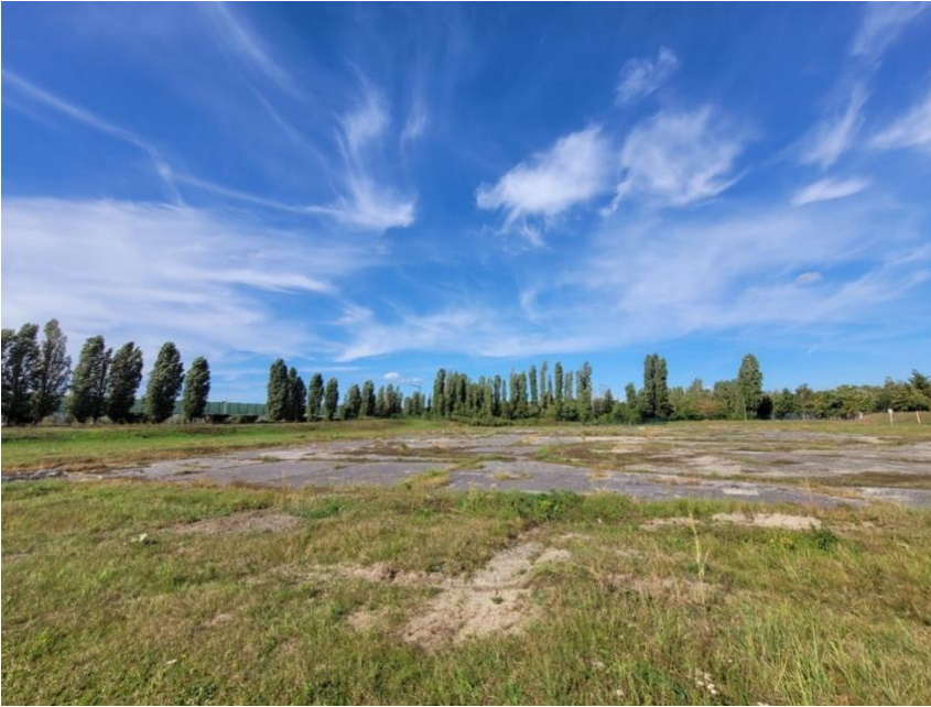
Abbildung 13: Mit Betonplatten teilversiegelter Bereich der Untersuchungsfläche. In den Zwischenräumen wächst bereits Vegetation auf.
