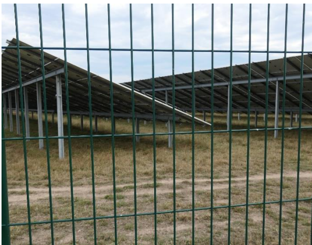
Abb. 41: Solarpark „Weesow-Willmersdorf“ (Biotop Nr. 039, Blickrichtung Osten)
