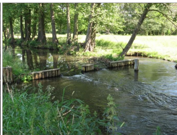
Abbildung 1.2: Provisorium Wehr 42 im Jahr 2008
