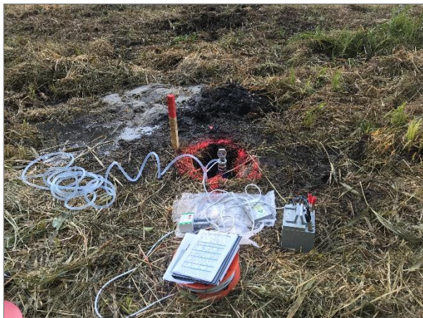
Abbildung 19: Aufbau Probenahme Grundwasser
