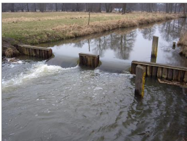
Abbildung 1.1: Provisorium Wehr 42 im Jahr 2005 (Quelle: WBVOC)
