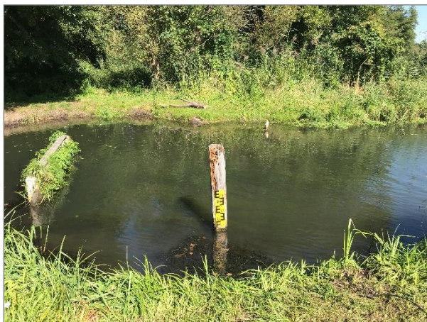
Abbildung 4.2: Pegellatte und umströmtes Wehr (links) innerhalb der Neuen Spree
