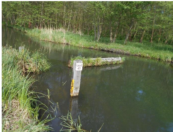
Abbildung 8.3: Umläufigkeit des Notstaus, kein Absturz erkennbar
