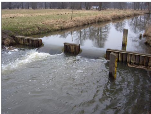
Abbildung 1.1: Provisorium Wehr 42 im Jahr 2005 (Quelle: WBVOC)
