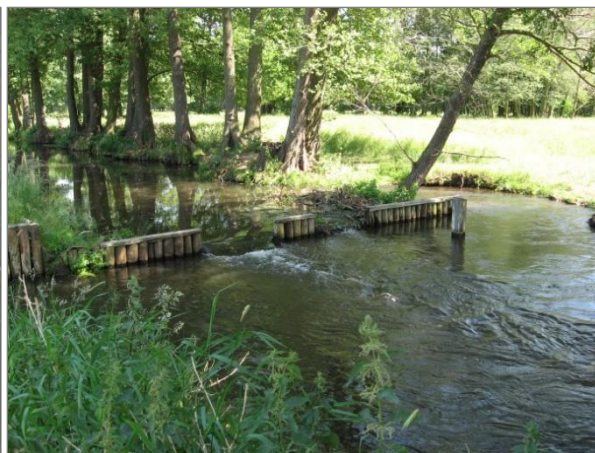
Abbildung 1.2: Provisorium Wehr 42 im Jahr 2008
