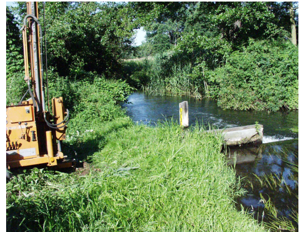
Bohrung 1 mit Rammsondierung 1 (davor)
