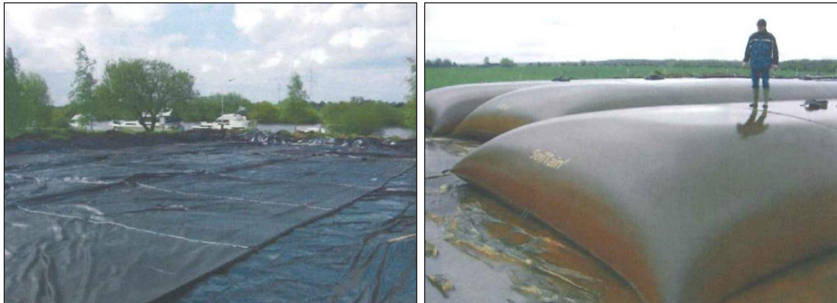
Abbildung 4.1: Vorbereitete Entwässerungsfläche mit flach ausgebreiteten Schläuchen (li.); gefüllte Entwässerungsschläuche (re.) (Quelle: HUESKER, 2011)
