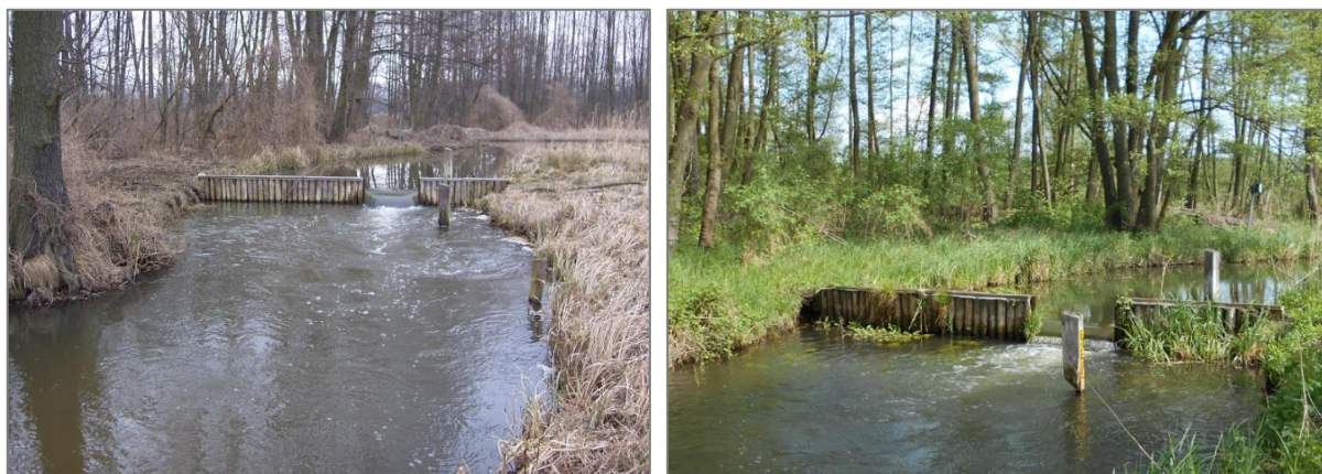
Abbildung 2.1: Vorhandenes Provisorium Wehr 46 (links: WBV 2005; rechts: iHC 2018)
