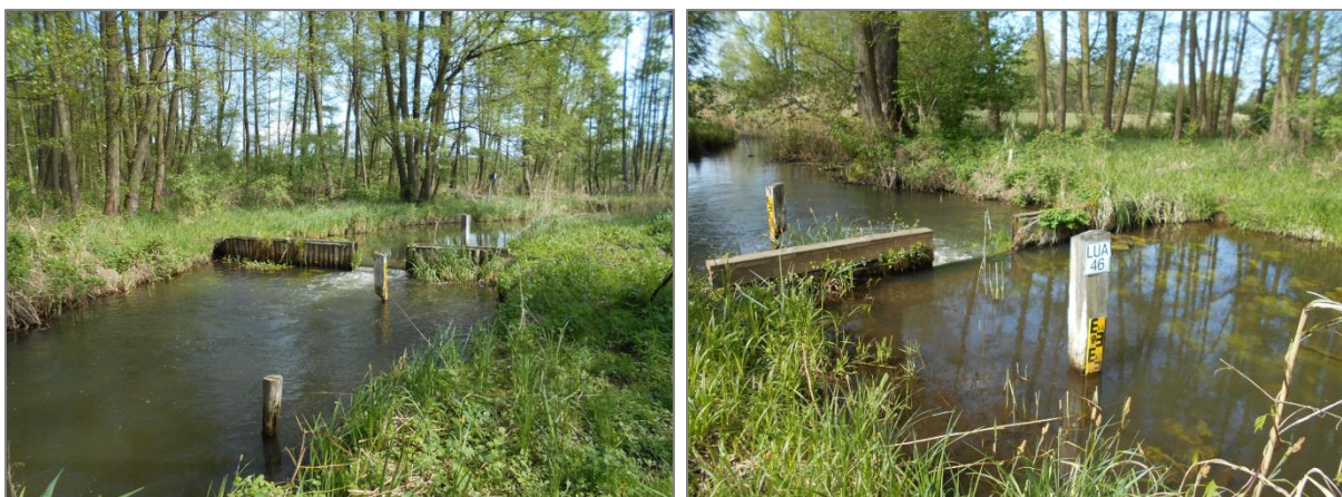
Abbildung 2.4: Provisorium Wehr 46 Ansicht von UW (li.) und OW (re.)
