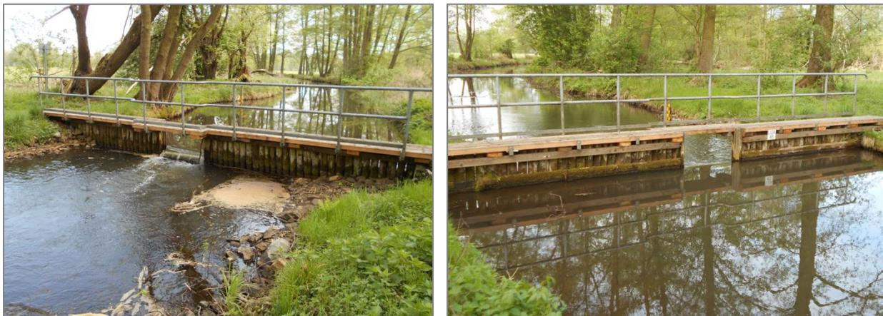
Abbildung 3.7: Provisorium Wehr 45 Ansicht von UW (li.) und OW (re.)
