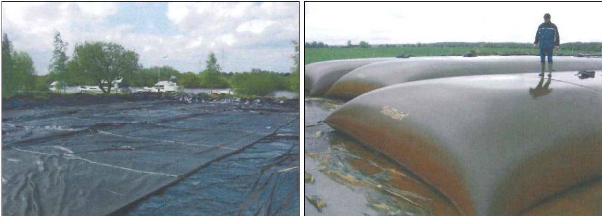
Abbildung 4.1: Vorbereitete Entwässerungsfläche mit flach ausgebreiteten Schläuchen (li.); gefüllte Entwässerungsschläuche (re.) (Quelle: HUESKER, 2011)
