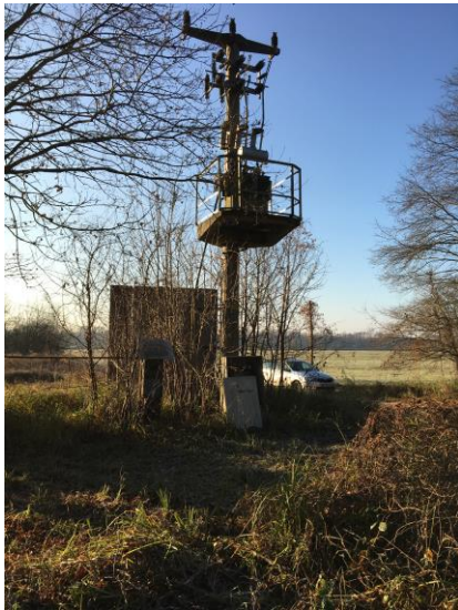
Abbildung 7-4: Betonmast-Trafostation
