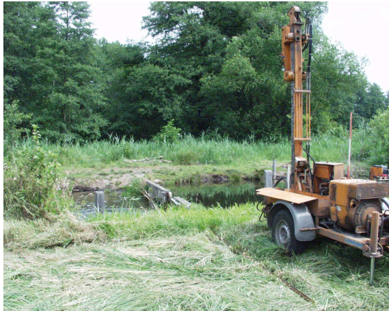
Bohrung 1 06/2008 hinter Bohrerät
