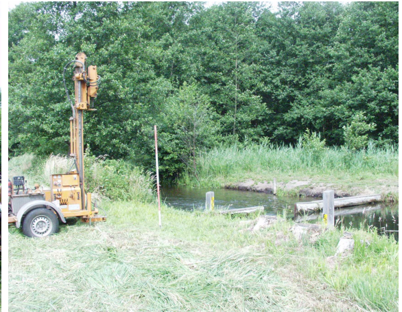
Bohrung 1 (Fluchtstab) mit Rammsondierung 1
