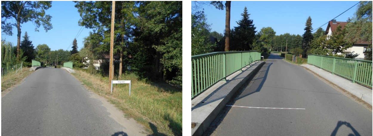
Abbildung 3.13: Brückenbauwerk 1 (BW 08/13) über den Ostgraben (iHC 2018)
