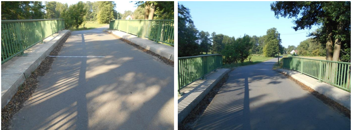
Abbildung 3.14: Brückenbauwerk 2 (BW 08/14) über das Krumme Fließ (iHC 2018)
