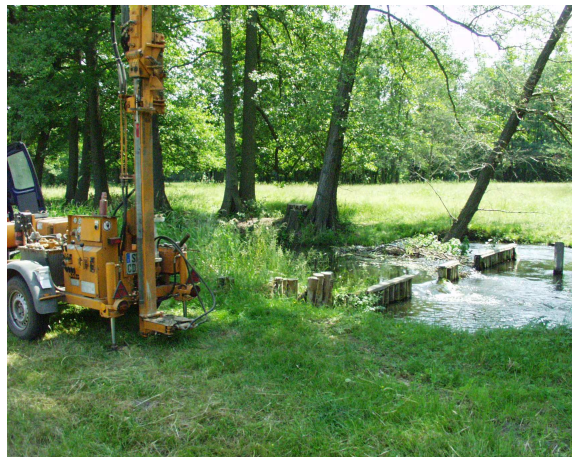
Bohrung 1 07/2008 hinter Bohrgerät
