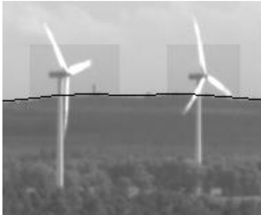
Abbildung 1: Automatisch generierte Ausschlussgebiete um Rotoren von WEA
