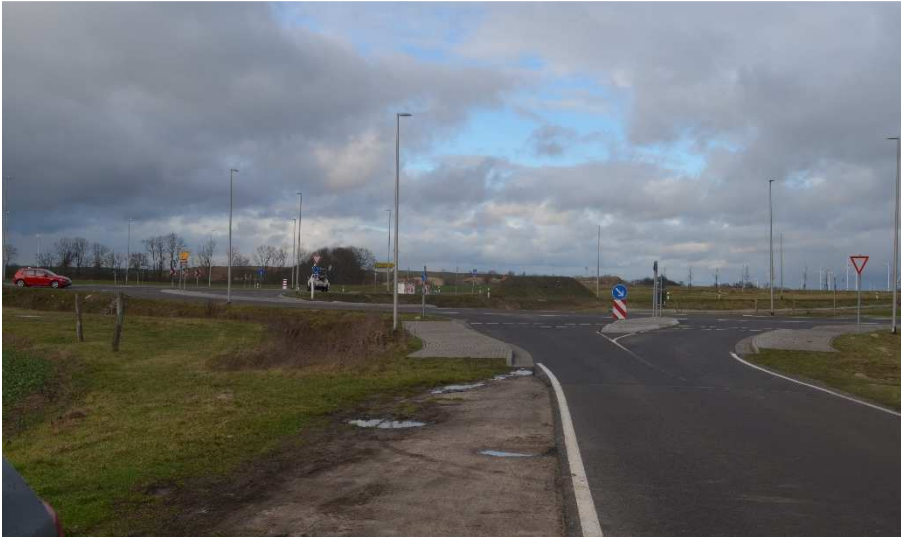
Abb. 11: Vorbelastung B2-Kreisel östlich der WKA Dobberzin, Fotostandort 54 nach N
