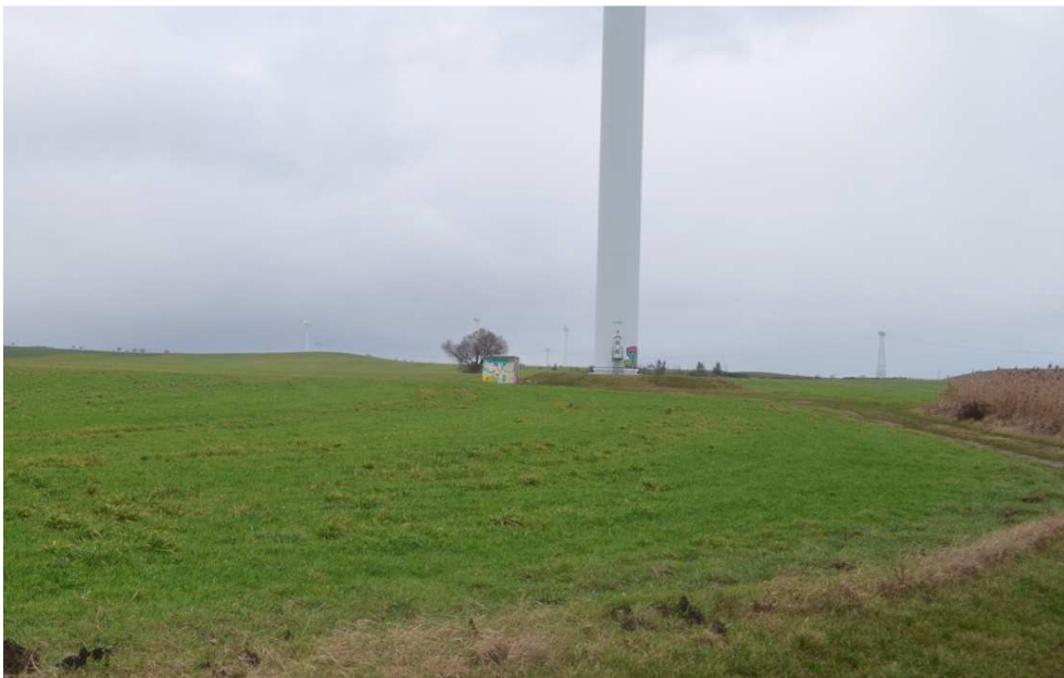
Abb. 3: Blick auf die Altanlage, Neuanlage links ca. 50 m entfernt (Fotostandort 12 nach N)
