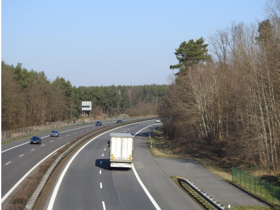
Abbildung 8: Blick in den Nahbereich mit der querenden Autobahn als technogene Vorbelastung sowie der im Forst versteckten bestehenden WEA
