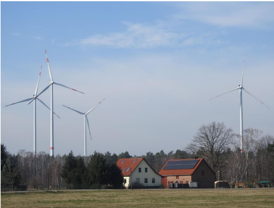
Abbildung 20: Häuser der Ortschaft Kemmen mit den bestehenden WEA, die eine visuelle Störwirkung im Landschaftsbild erzeugen
