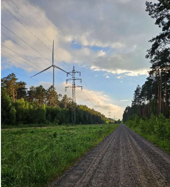
Abbildung 25 kV-Trasse Richtung Westen, bereits ausreichend ausgebaut
