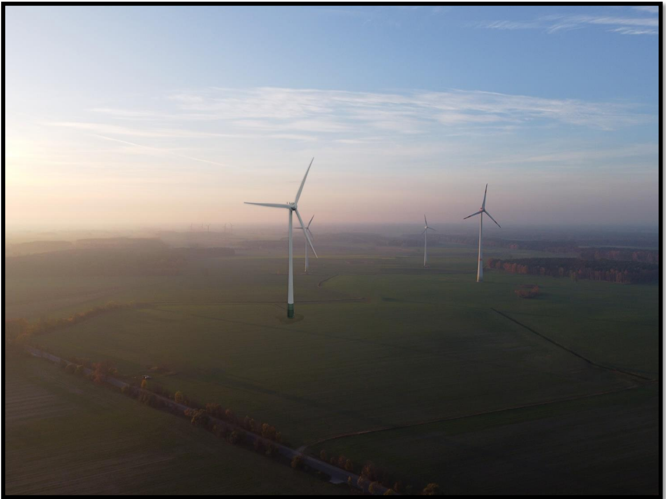
Abbildung 3 Windpark Klosterfelde aus der Vogelperspektive im Planzustand (im Vordergrund die geplante WEA, 4 WEA wurden rückgebaut)
