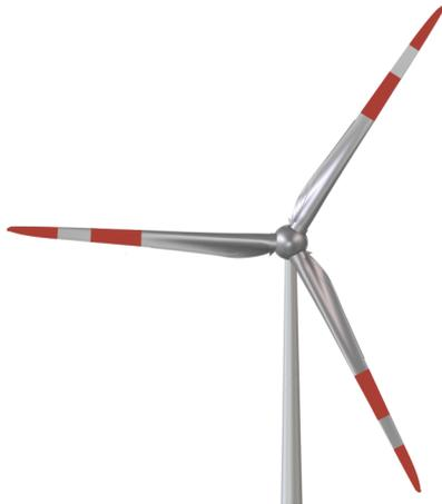
**Abb. 5: Farbliche Kennzeichnung am Rotorblatt**
