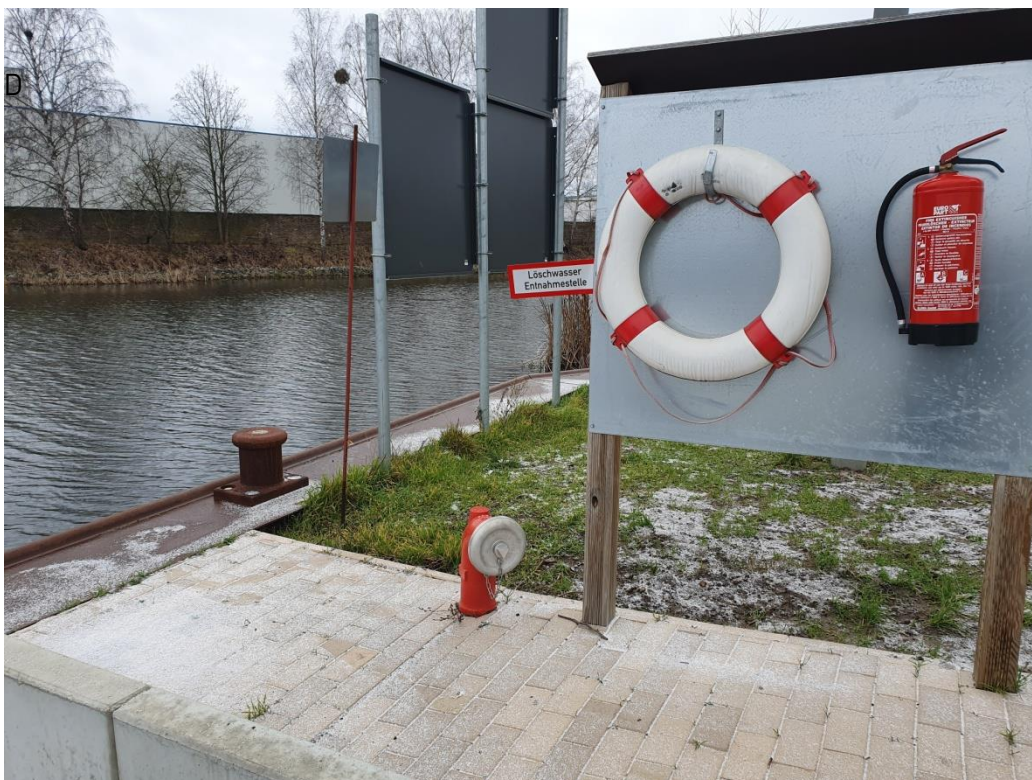
Abbildung 2: Saugstelle am Veltener Stichkanal, (Bildrechte TPG mbH)
