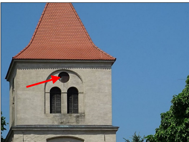
Abb. 3 Brutplatz des Turmfalken am Kirchturm Biegen
