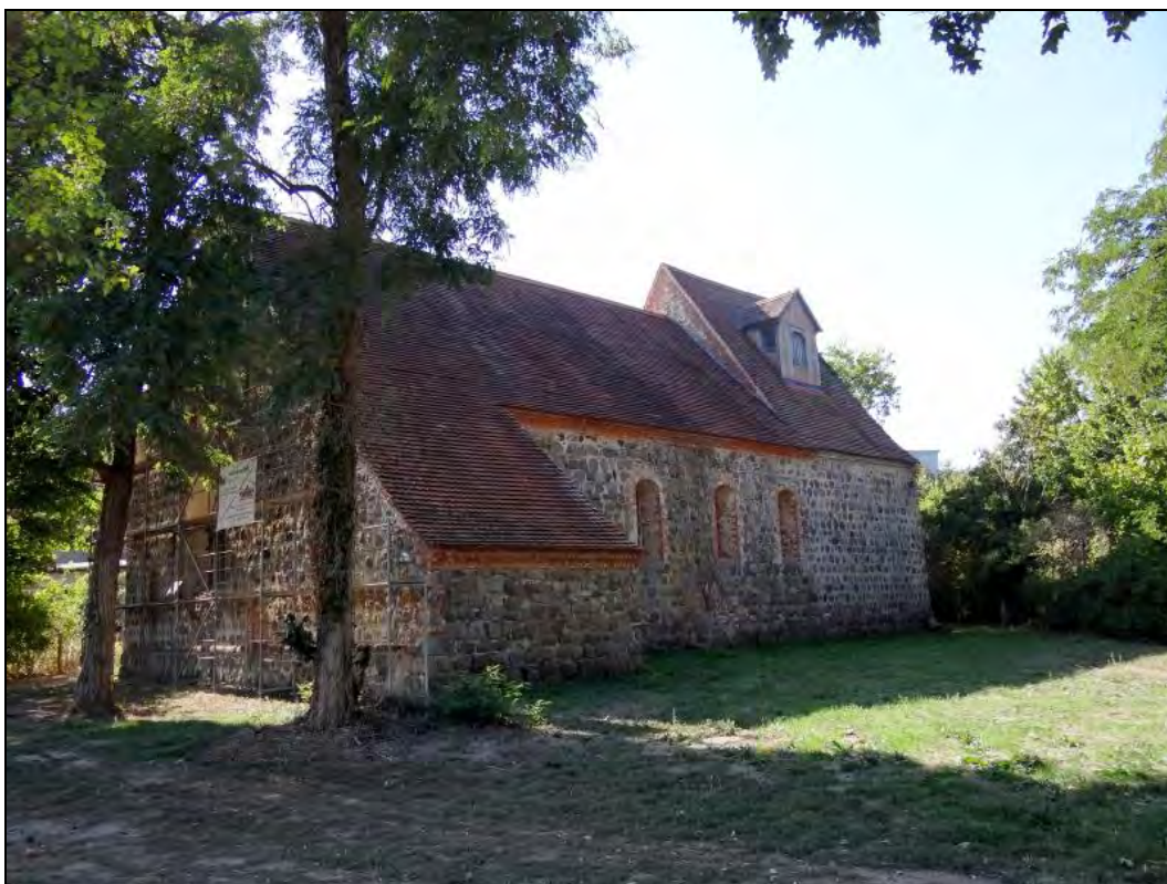
Abbildung 69: Dorfkirche Krampfer – geringe Bauhöhe, selbst im Ort unauffällig
