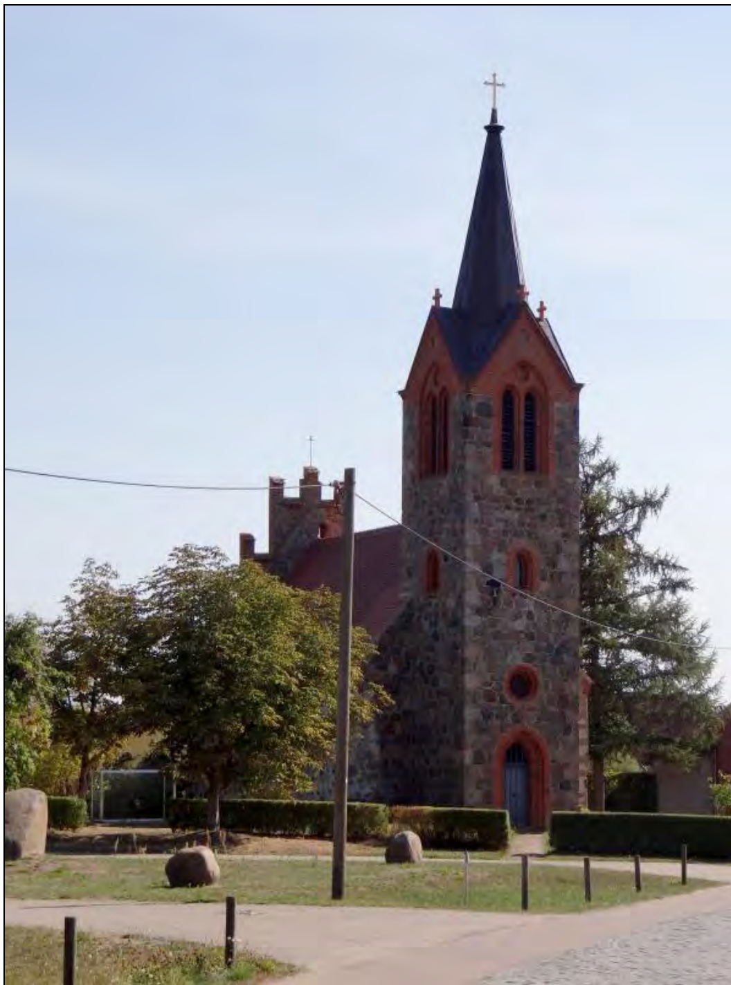
Abbildung 72: Dorfkirche Rambow – durch Straßenführung der L 101 von Nord nach Süd – keine möglichen Sichtachsen mit geplanten WEA
