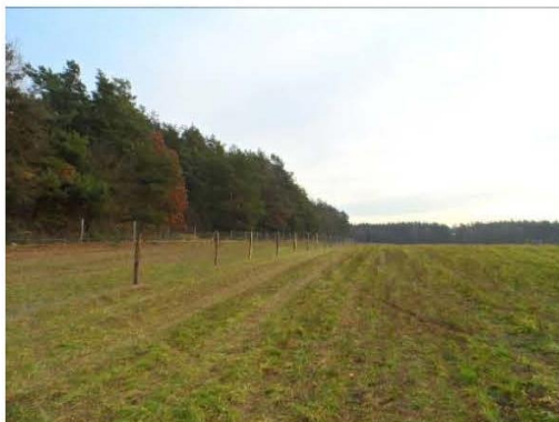
Abb.5: Zaunbau für Waldrandbepflanzung
