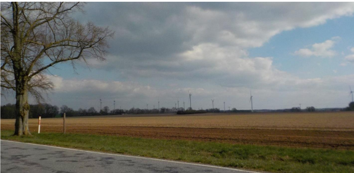
Abb. 45: Blick auf den Windpark von Nordwesten (vom Fotopunkt 28)
