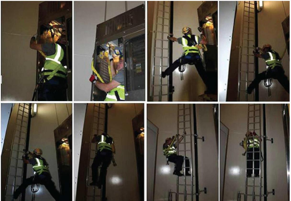
**Abbildung 7.24: Ablauf für die Evakuierung aus dem Serviceaufzug**
