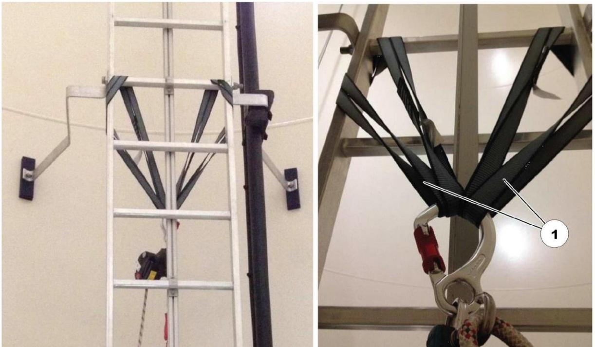
**Abbildung 7.21: Die Abstiegsvorrichtung mit 2 Schlingen an der Leiter befestigen**
