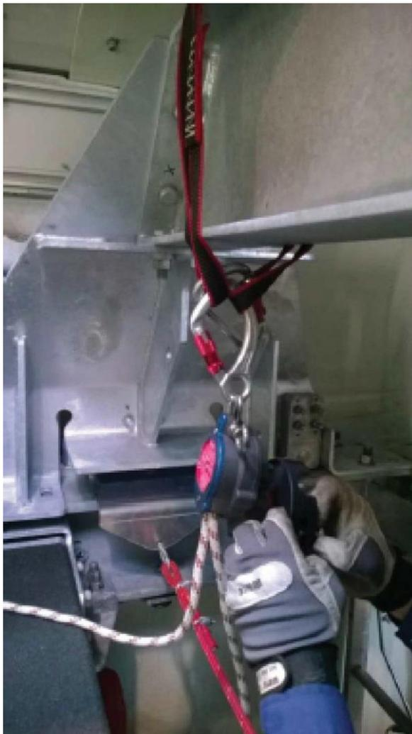
Abbildung 7.20: Die Abstiegsvorrichtung am beweglichen Ausleger befestigen
