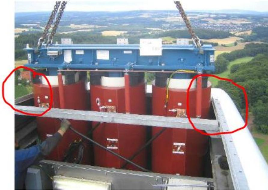
Abbildung 17-1: Führen des Transformators in das Maschinenhaus
