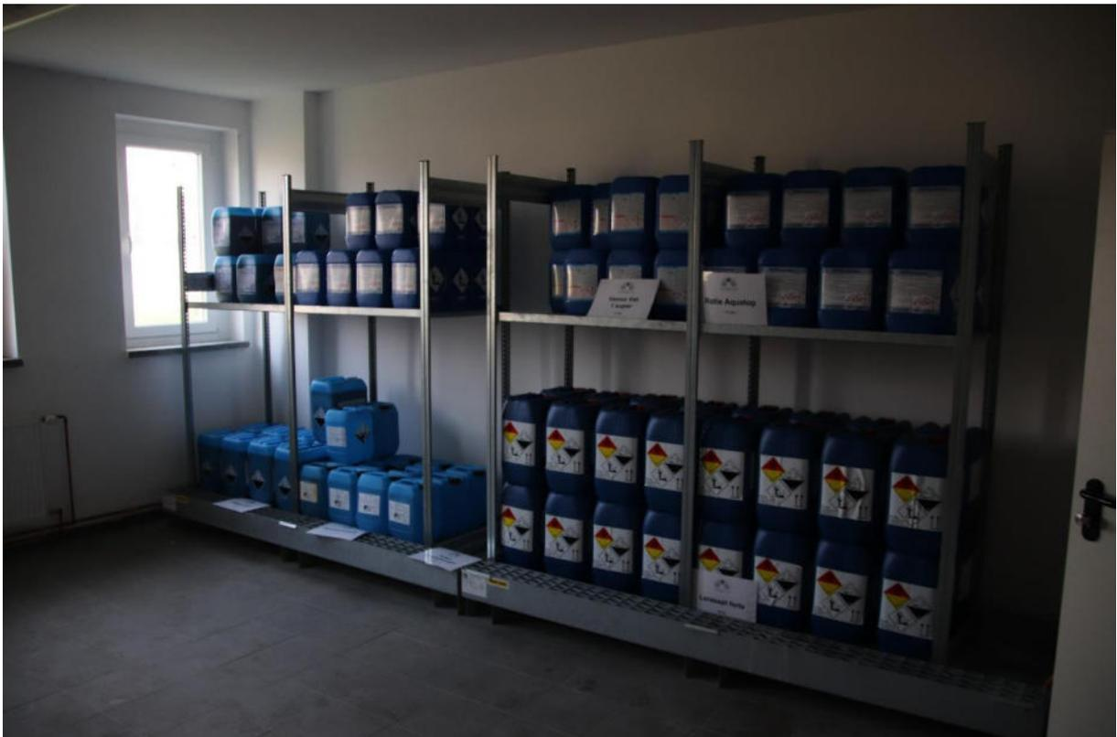
Kleingebinde-Gefahrstoffregale für wgS mit Bodenauffangwanne aus feuerverzinktem Stahlblech
