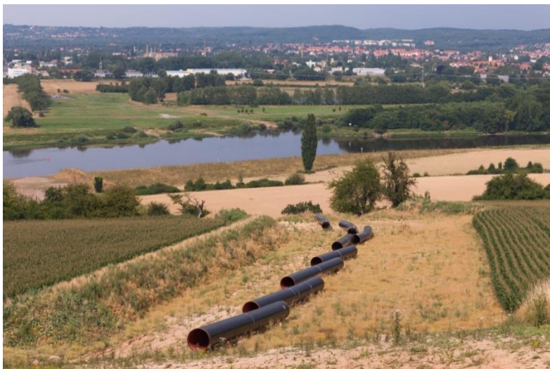
Abbildung 15: Ausfahren der Rohre
