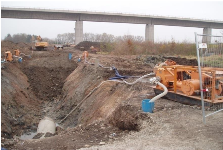
Abbildung 18: Wasserhaltungsmaßnahmen
