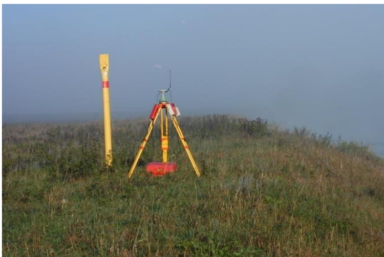
Abbildung 11: Absteckung der Trasse
