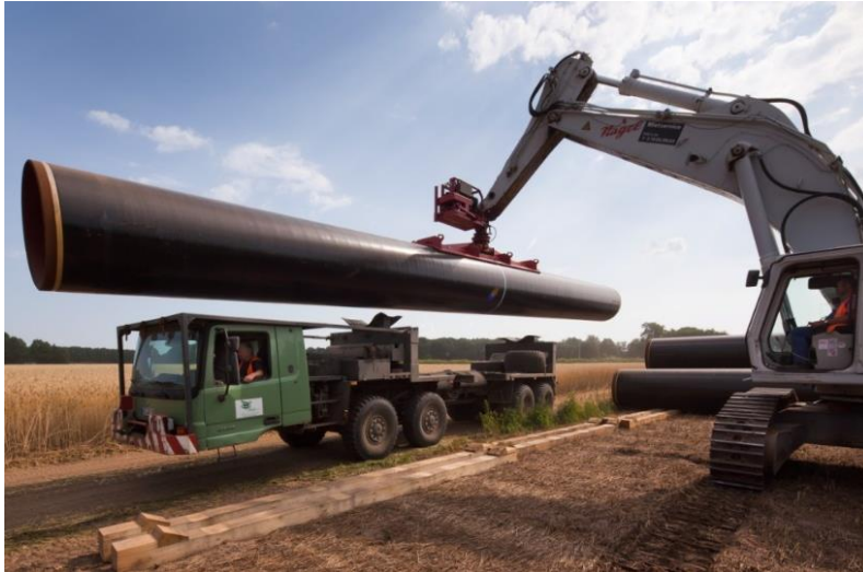
Abbildung 14: Ausfahren der Rohre
