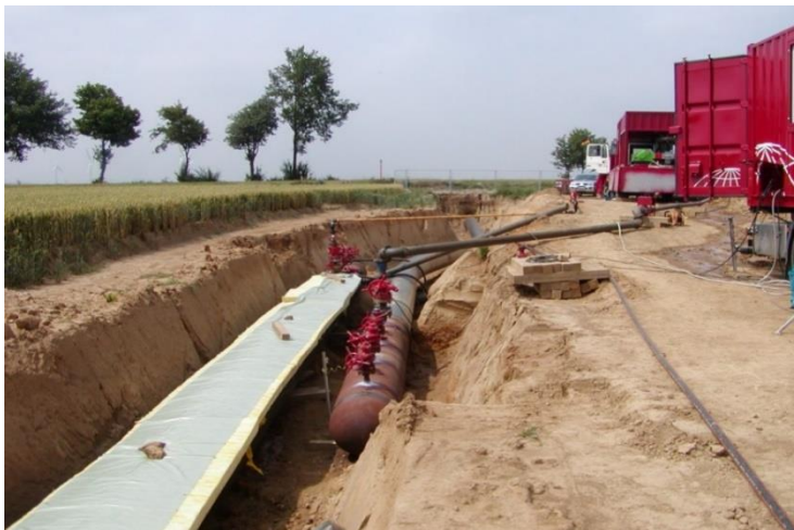
Abbildung 23: Wasserdruckprüfung
