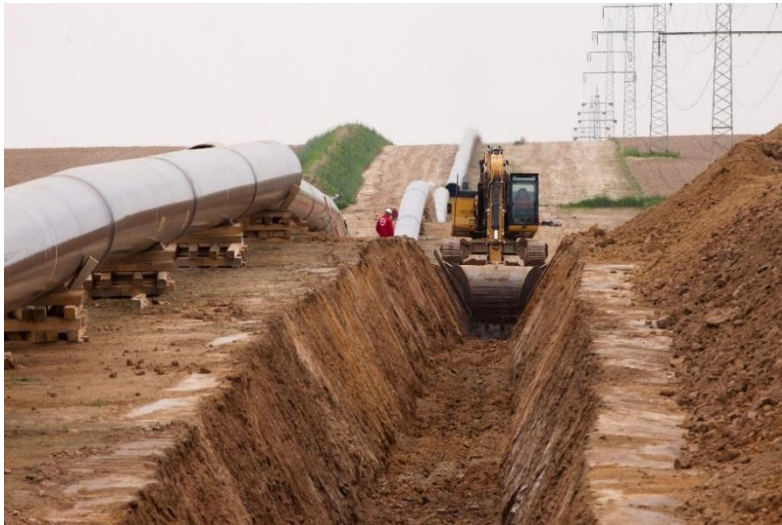
Abbildung 19: Aushebung des Grabens
