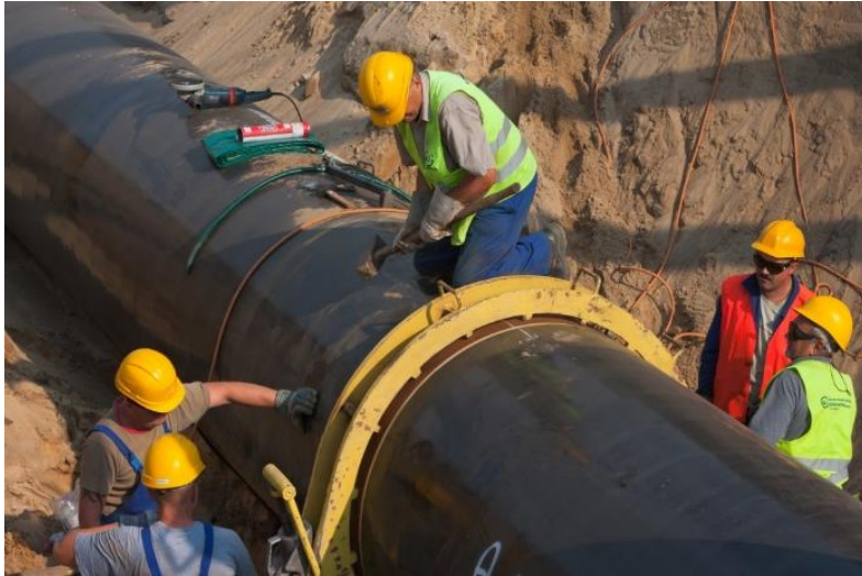
Abbildung 21: Verschweißen der Rohrabschnitte
