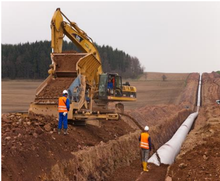
Abbildung 22: Verfüllung des Grabens
