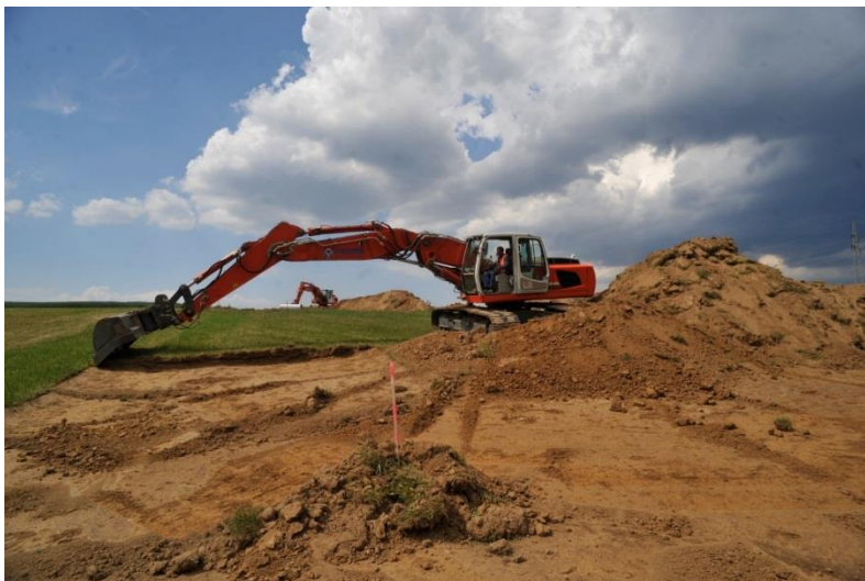
Abbildung 13: Abtragen des Oberbodens
