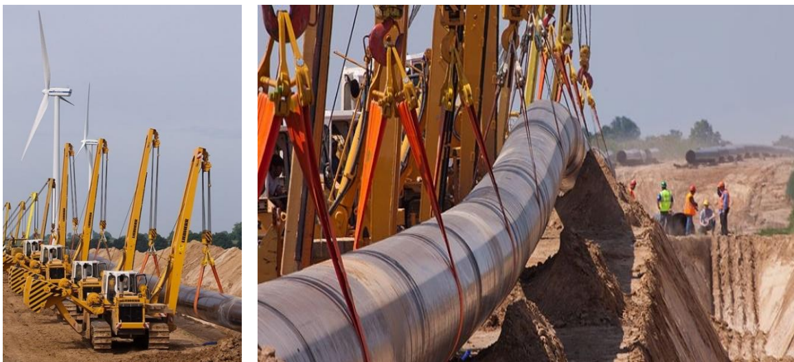
Abbildung 20: Absenken des Rohrstranges (a+b)
