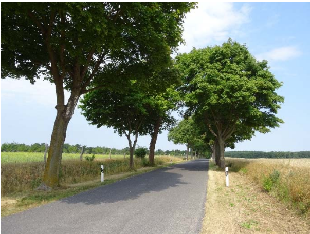
Abb. 26: alleebestandene Landstraße, Fotopunkt 47 mit Blick nach Norden
