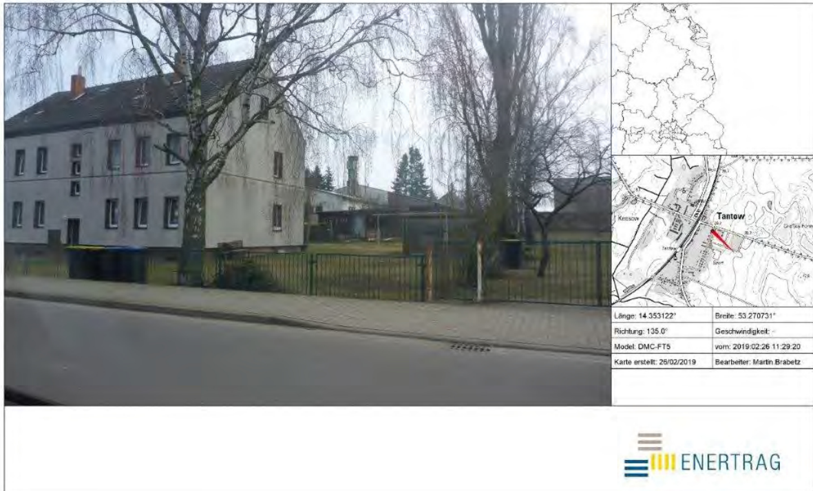
Abb. A2 41: Wohnhaus Schulstraße 20, landwirtschaftlicher Betrieb im Hintergrund (IO L)
