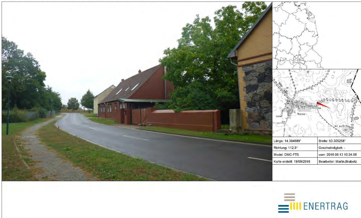
Abb. A2 28: Blick von der Straße auf Wohnhaus Dorfstr. 13 (IO E)
