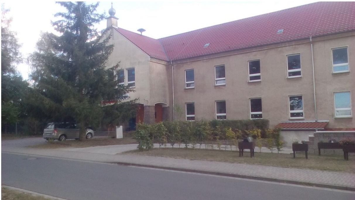
Abbildung 15: Schulgebäude in Tantow mit einem Sommerquartier der Zwergfledermaus
