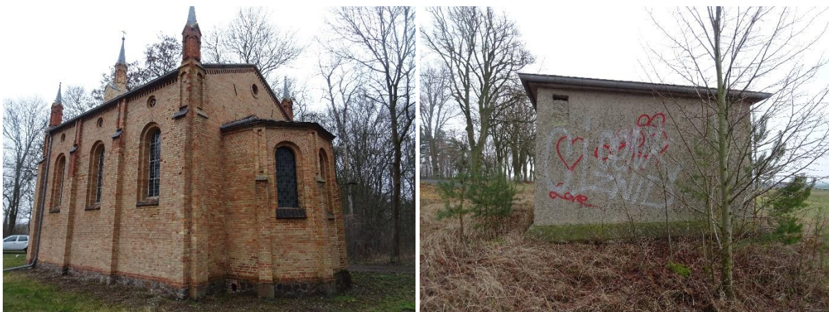
Abbildung 16: Kirche mit Quartierpotential in Tantow (links) und Trafohaus mit Fledermausquartier (rechts).
